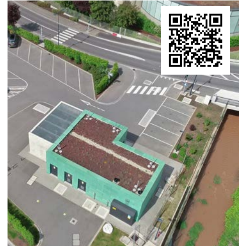
Vue aérienne sur le bassin d'orage / Lufbild vom Regenüberlaufbecken
