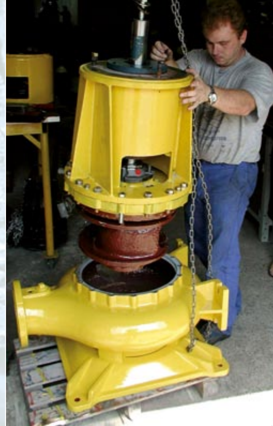
Reparatur einer Pumpe Réparation d'une pompe
