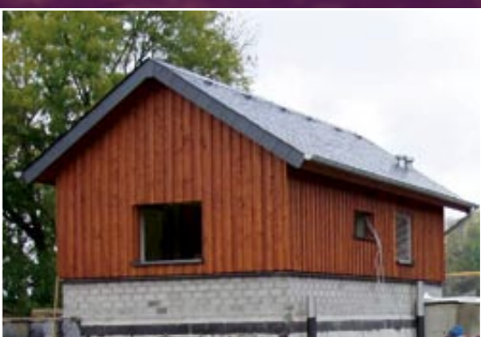
Neues Pumpwerk Colmar-Berg Nouvelle station de pompage Colmar-Berg
