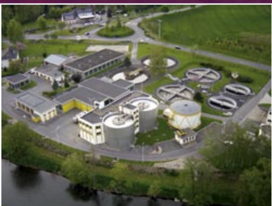
Kläranlage Bleesbruck Station d'épuration Bleesbruck
