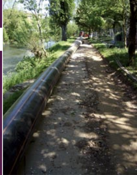
Baustelle der Doppelleitung Chantier de la conduite de dédoublement
