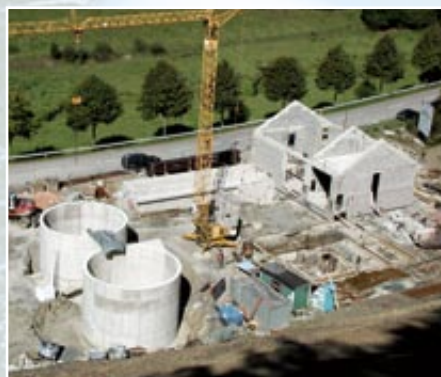
Kläranlagenbaustelle Chantier de station d'épuration
