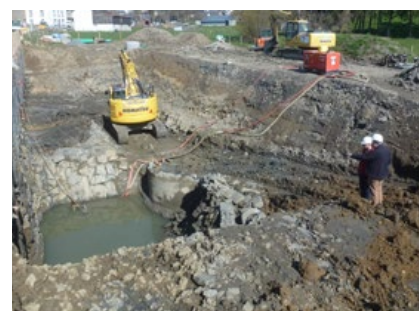
Aushubarbeiten Rüb Trotten
