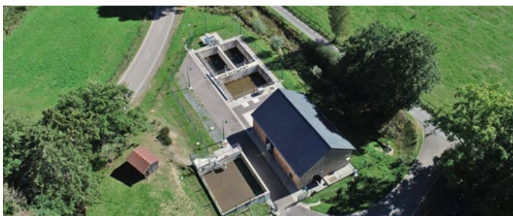
Luftbild Kläranlage Brachtenbach
