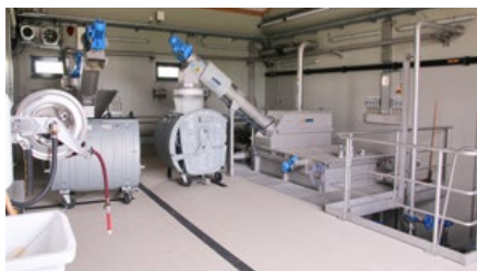
Mechanische Vorreinigung
