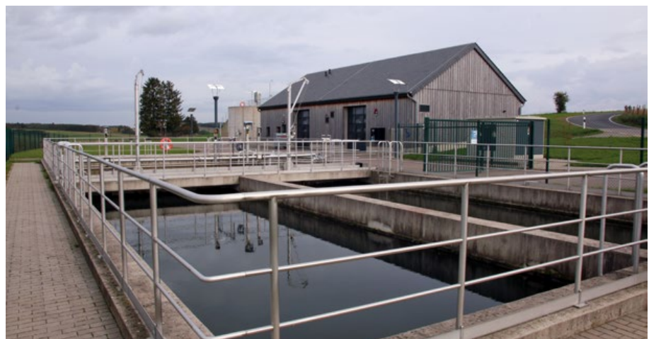
Biologische Reinigung KA Trotten
