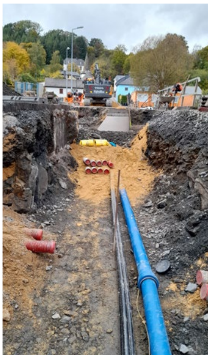
Kanalverlegearbeiten in Sassel
