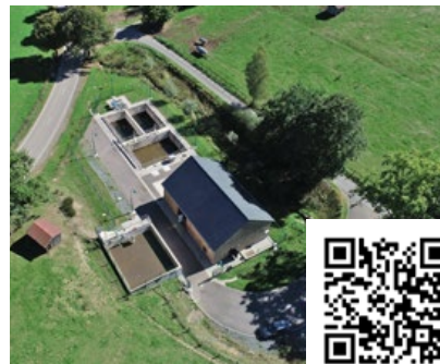
Luftbild Kläranlage Brachtenbach
