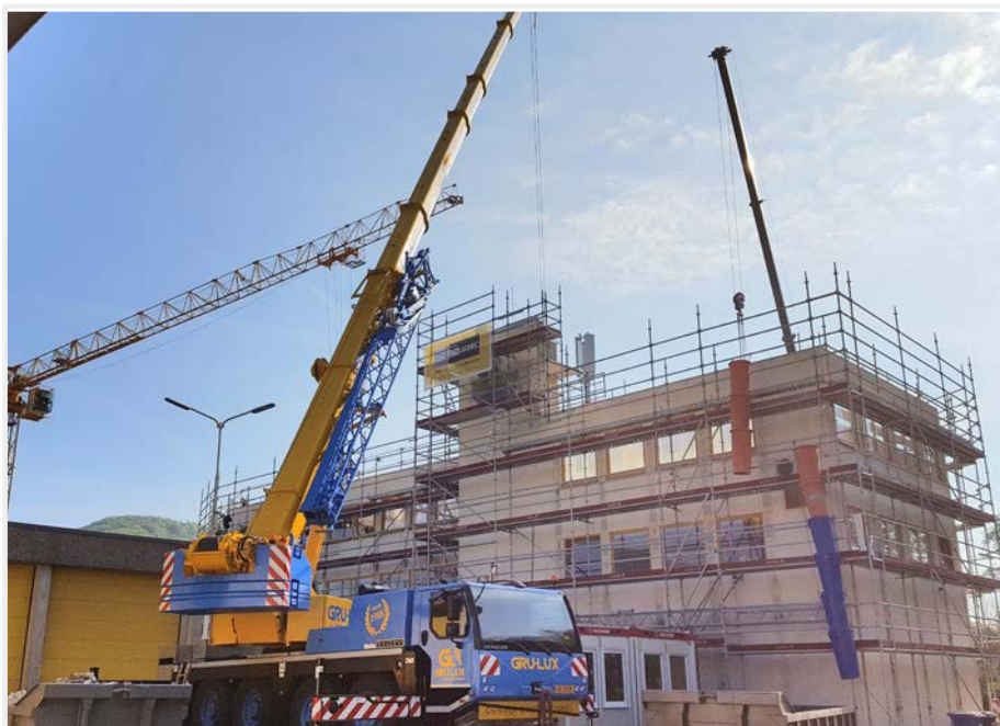
Travaux de reconstruction de la dalle de plafond
