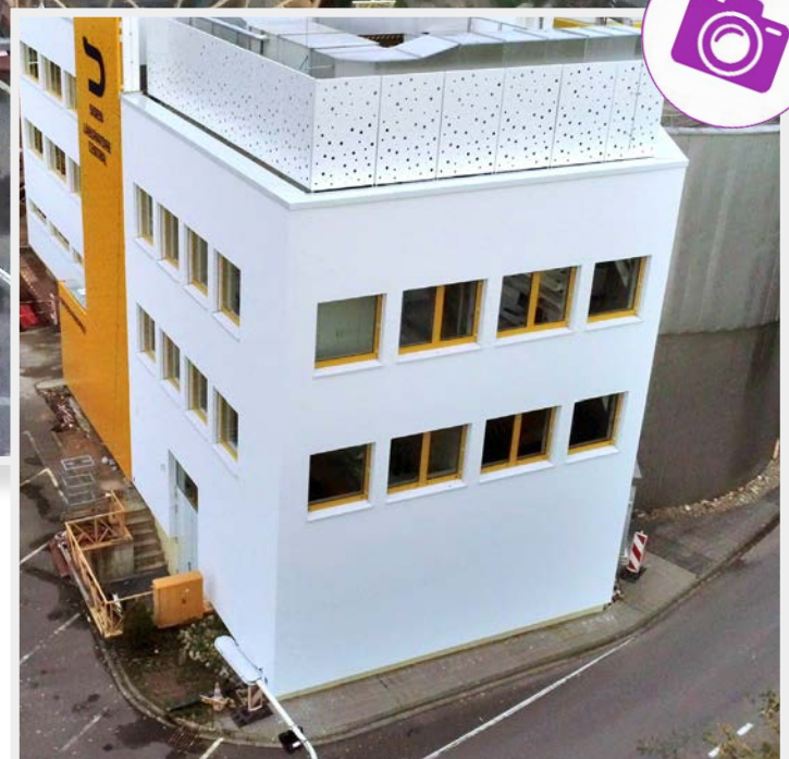
Façades côtés Sud et Ouest
