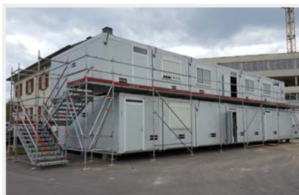
Conteneurs provisoires des bureaux et vestiaires
