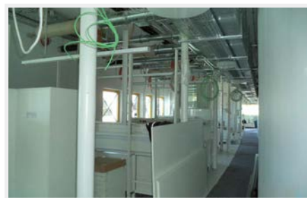
Montage des équipements de laboratoire
