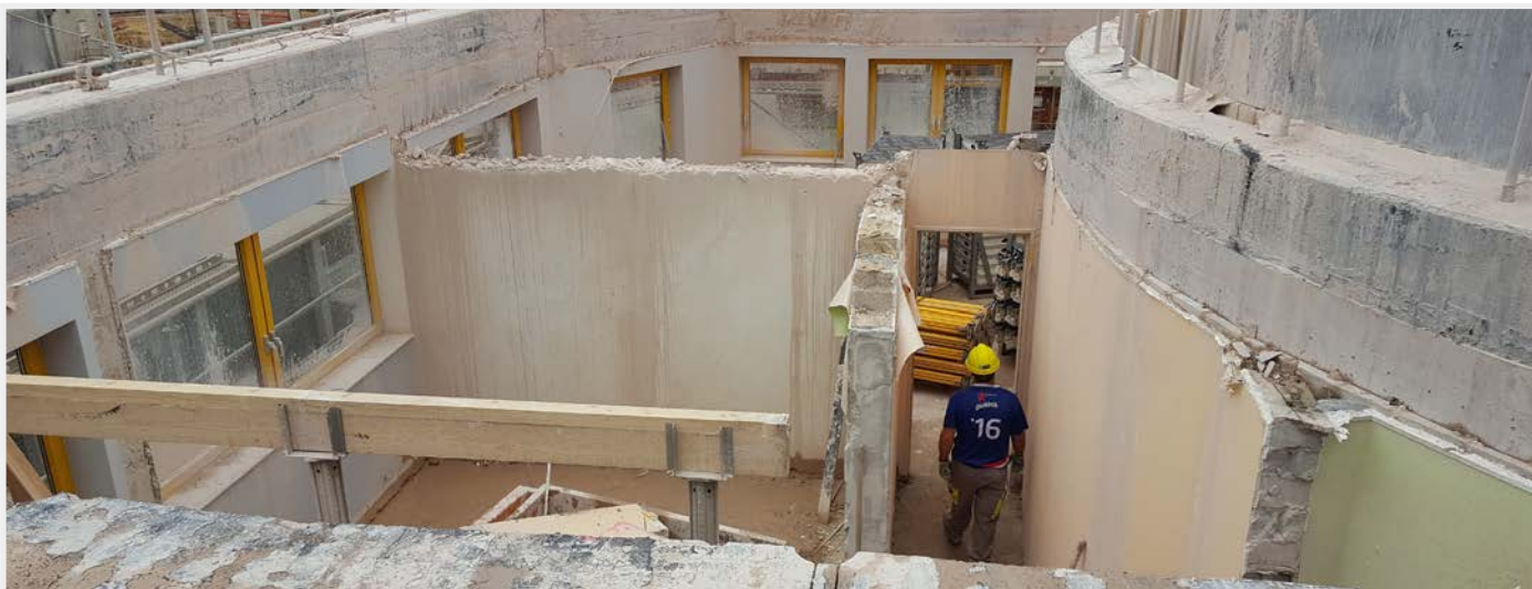
Vue sur le second étage dont la dalle de plafond a été enlevée
