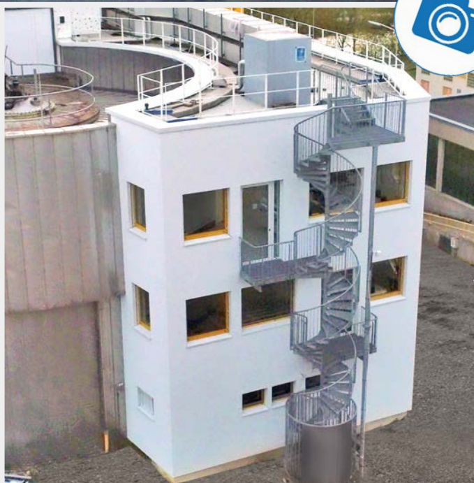
Façade côté Nord : Escalier de secours
