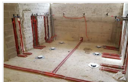
Sanitaires en chantier
