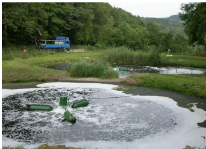
Teich mit Centrox-Belüfter im Betrieb
