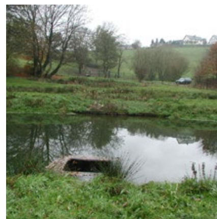
Ansicht der ursprünglichen Anlage (Februar 2004)
