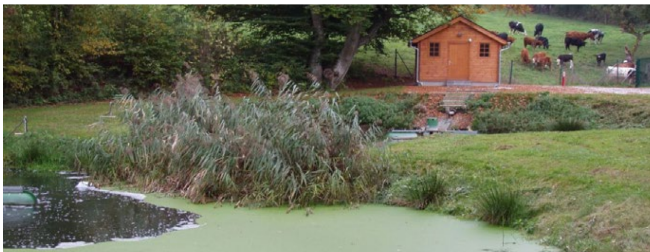
Alte Kläranlage Putscheid (Oktober 2006)
