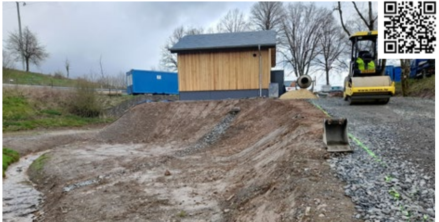
RÜB & PW Weiler - Inbetriebnahme vorgesehen für Ende 2023
