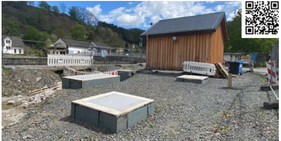
RÜB & PW Stolzembourg - Inbetriebnahme vorgesehen für Oktober 2023
