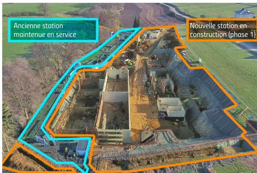
Situation du chantier en avril 2018
