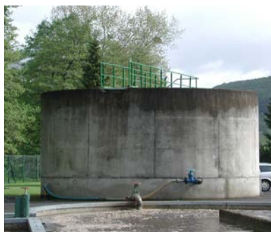
Épaisseurs à boues (station historique)
