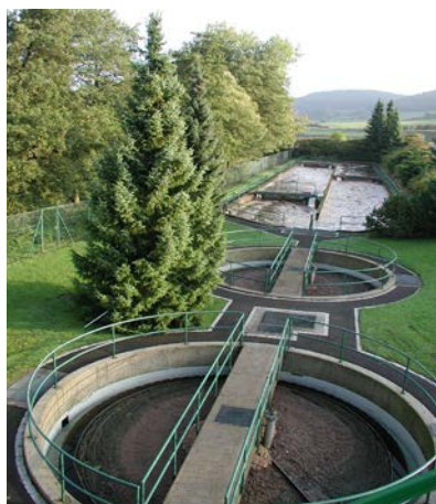
Vue sur les décanteurs secondaires et le bioréacteur (Extension 1980)
