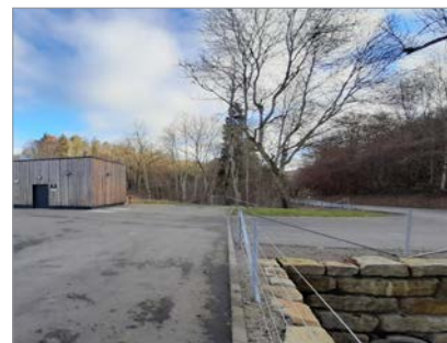
Bassin d'orage avec station de pompage de Reuland
