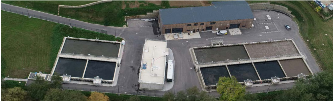
Vue aérienne sur la station d'épuration intercommunale de Medernach
