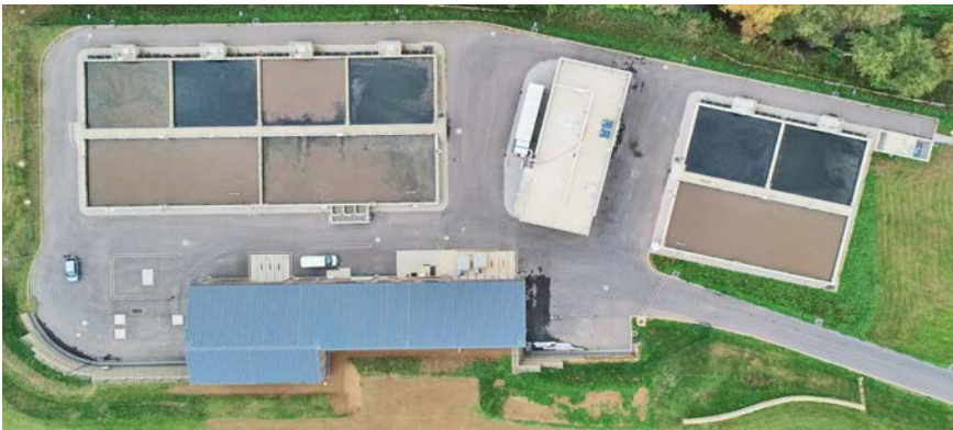
Vue aérienne sur la station d'épuration
