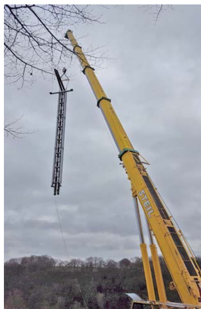
Mise en place du raccordement
