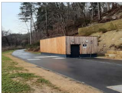
Bassin d'orage de Heffingen-Soup
