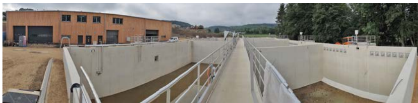
Vue panoramique sur le chantier de la station d'épuration en août 2019
