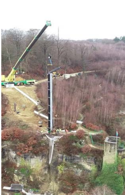
Vue aérienne sur l'installation en cours du raccordement
