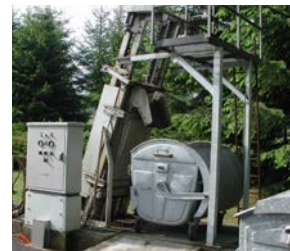
Dégrilleur automatique
