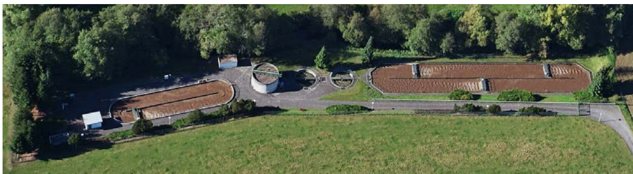
Situation en 2008 avant la construction de la nouvelle station d'épuration intercommunale de Medernach
