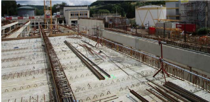
Vue sur la dalle / Sicht auf Werkhofebene
