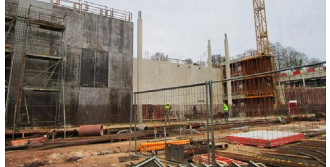
Bassin biologique en construction / Biologisches Becken im Bau
