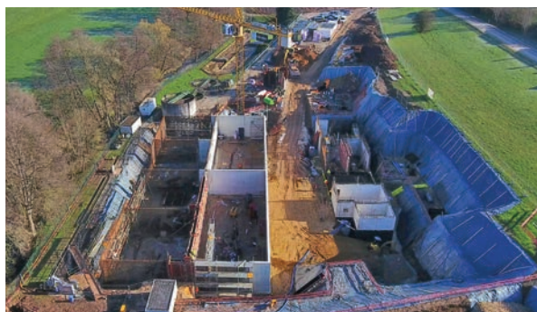
Travaux de bétonnage des bassins / Betonarbeiten an den verschiedenen Bauwerken
