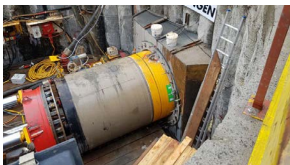
Vue du fonçage / Durchpressung
