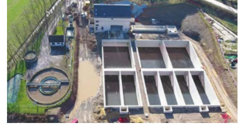
Vue sur le chantier de la station d'épuration de Feulen / Luftansicht der Baustelle
