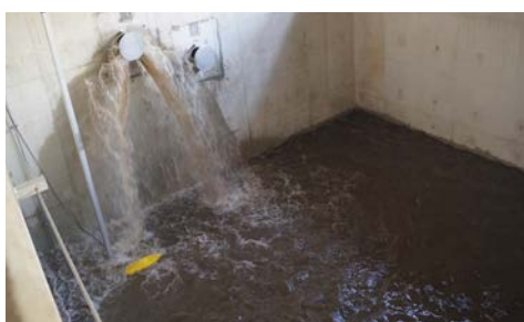
Mise en service biologie 1 / Befüllung der 1. Biologie
