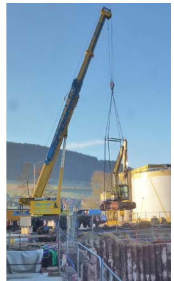
Evacuation de l'excavatrice du fond de fouille / Herausheben des Baggers aus der Baugrube
