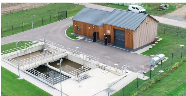
Vue aérienne de la station d'épuration de Buschrodt / Luftbild der Kläranlage Buschrodt
