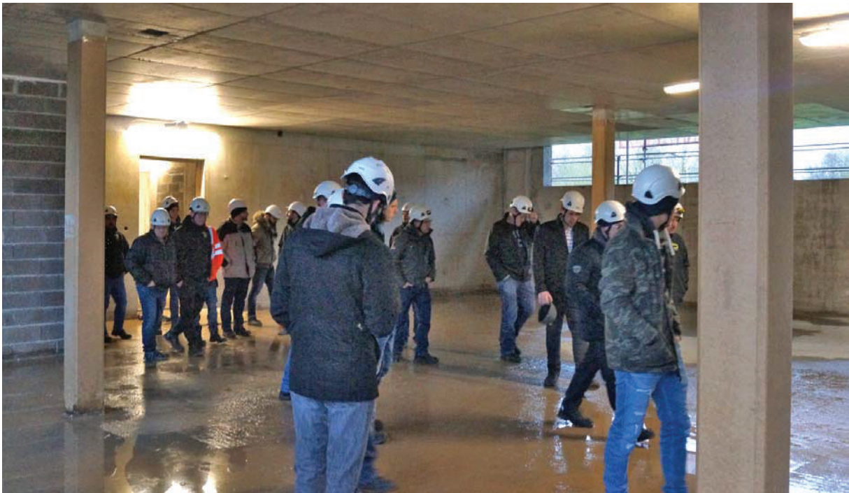
Visite du chantier de la station d'épuration de Blesbruck (15.12.2017)
