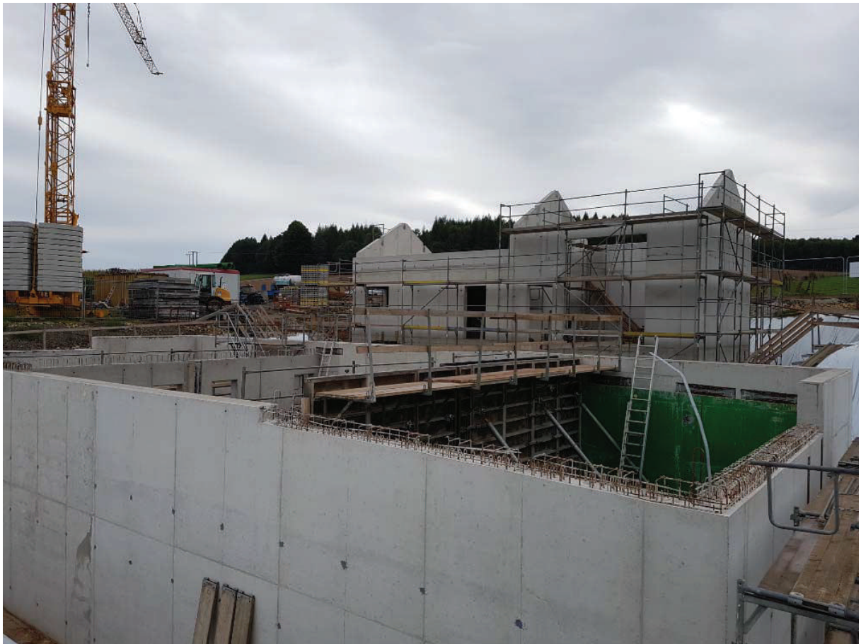
Photo: Travaux de génie civil au niveau de la voie de traitement biologique et du bâtiment technique à Buschrodt
