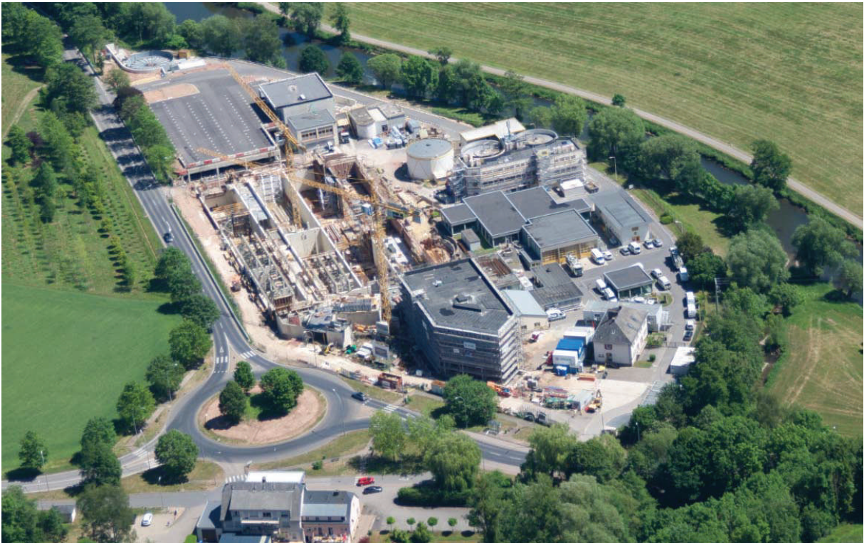
Photo: Chantier Blesbruck Phase II – Vue aérienne
