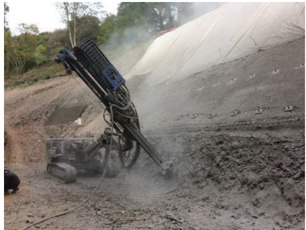
Photos: Travaux de terrassement des ouvrages et mesures de stabilisation de la voie d'accès à la station d'épuration de Bourscheid
