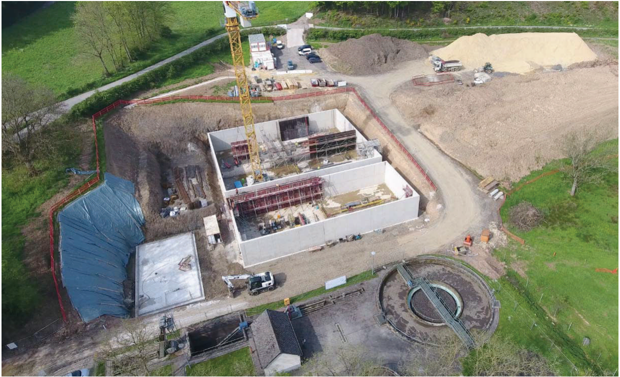
Photo: Chantier de la future station d'épuration à Niederfeulen (9.000 EH)
