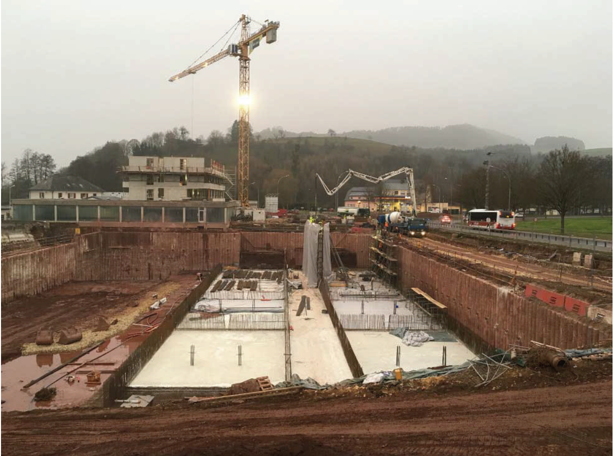
Photo: Chantier Blesbruck Phase II - Bétonnage radier des bassins biologiques
