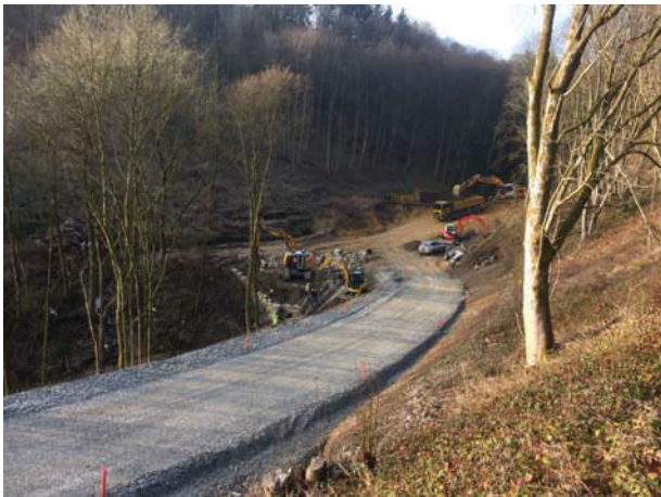
Photos: Travaux de terrassement des ouvrages et mesures de stabilisation de la voie d'accès à la station d'épuration de Bourscheid
