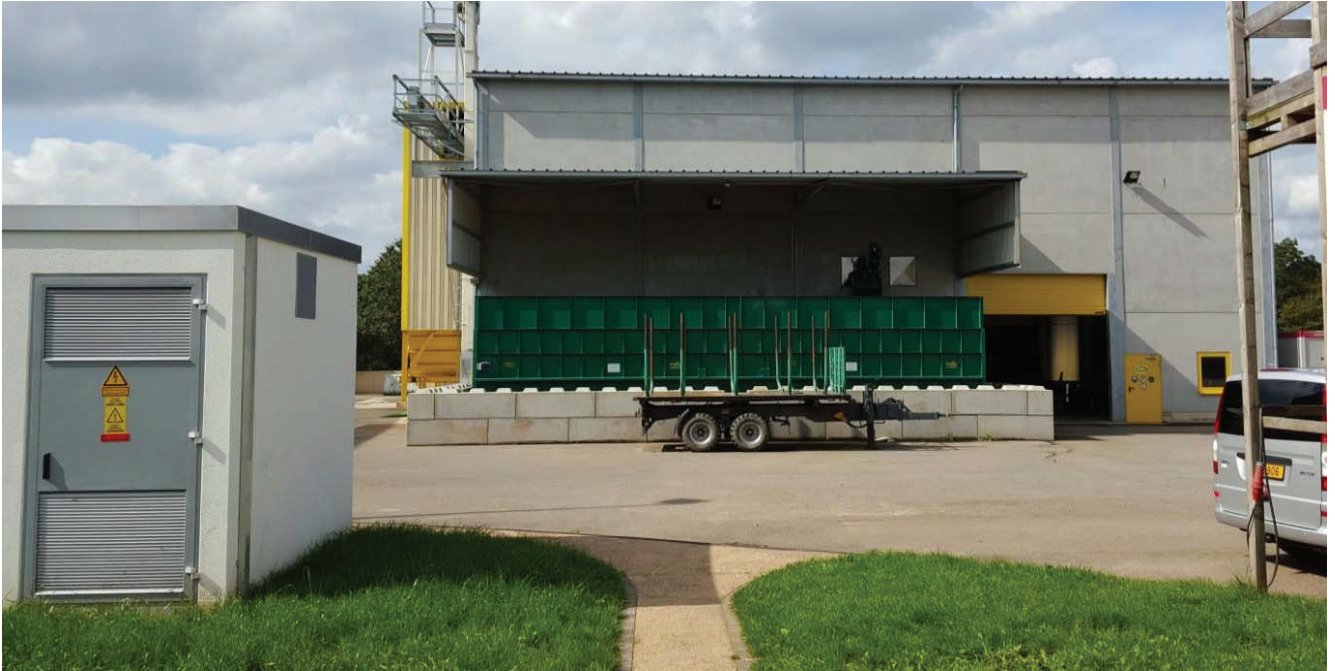
Hall des installations techniques d'ENERCOM et VALORTECH construit en 2012.
