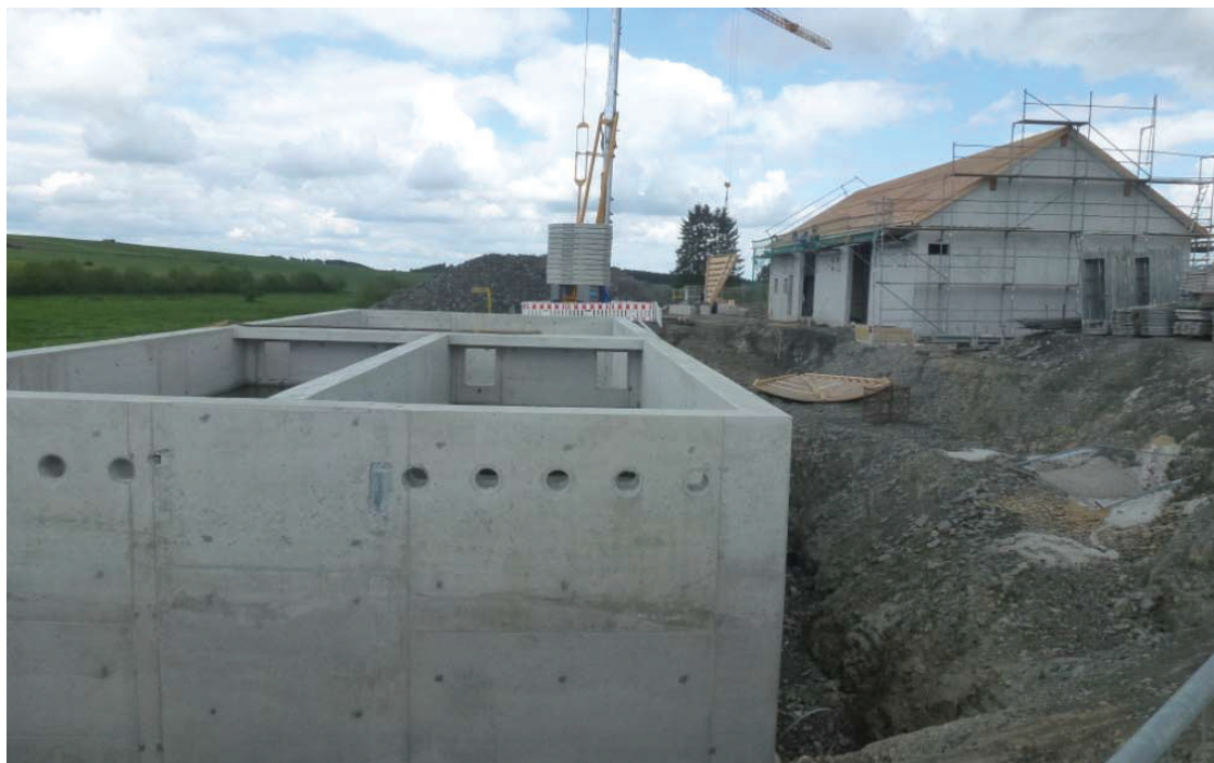
Photo: Station d'épuration à Troine - Voie de traitement biologique et bâtiment technique en cours de réalisation
