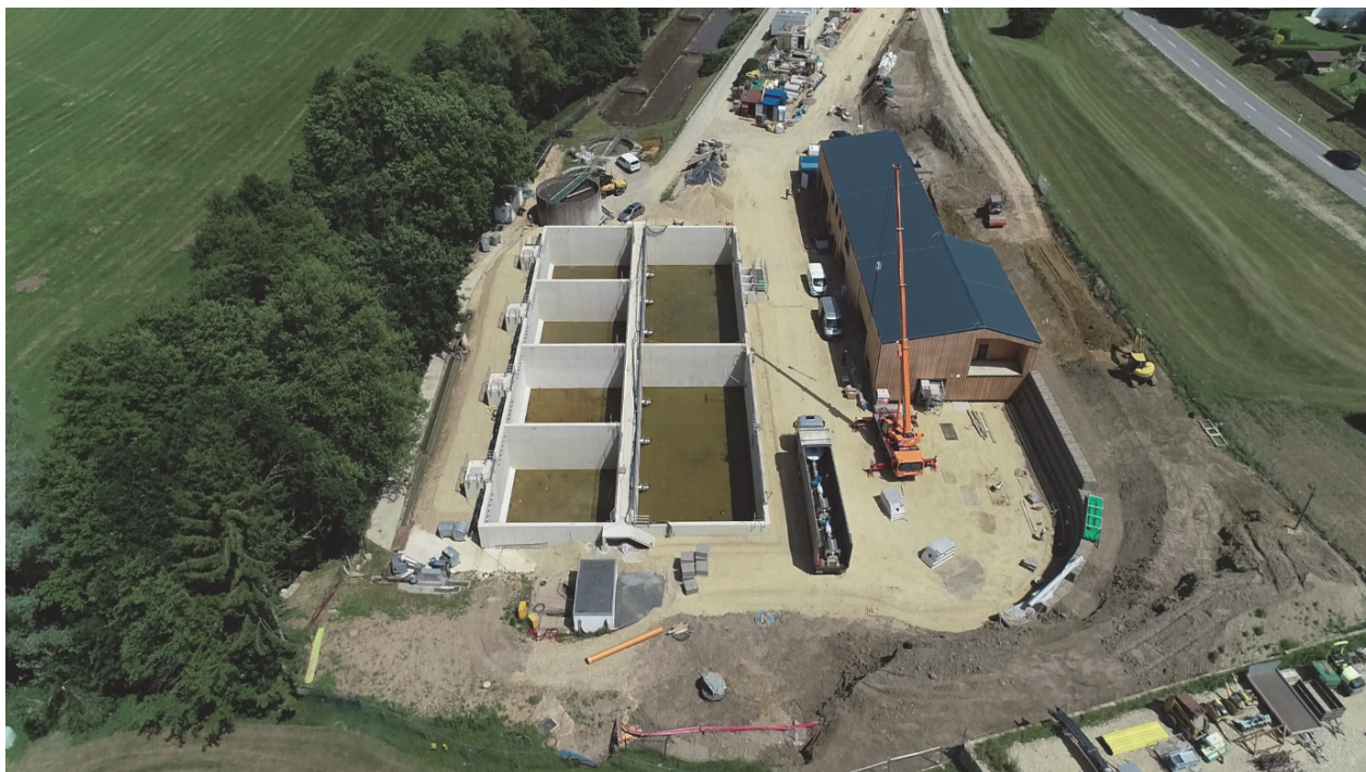
Photos: Station d'épuration à Medernach 13.000 EH - Voie de traitement biologique (phase 1) en cours d'équipement et bâtiment technique finalisé
