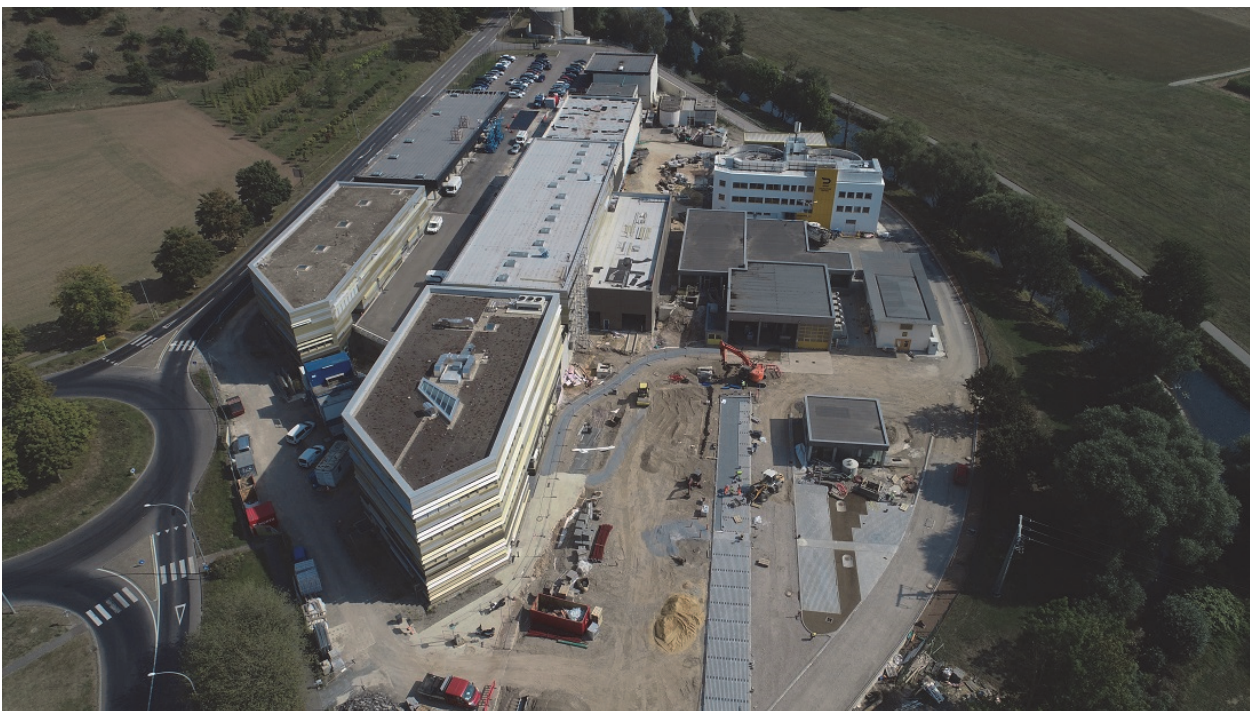
Photo: Chantier Bleesbruck Phase III – Vue aérienne vers l'est
