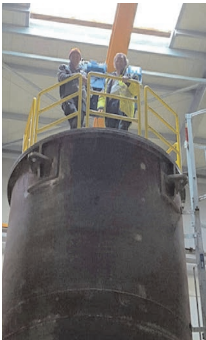
Vue sur le gazéificateur.
