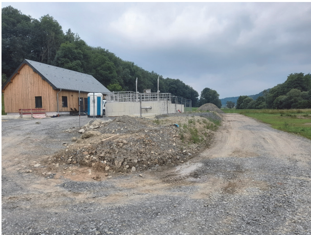
Photo: Station d'épuration à Hoesdorf 300 EH – Vue d'ensemble du bâtiment technique et du bassin biologique
