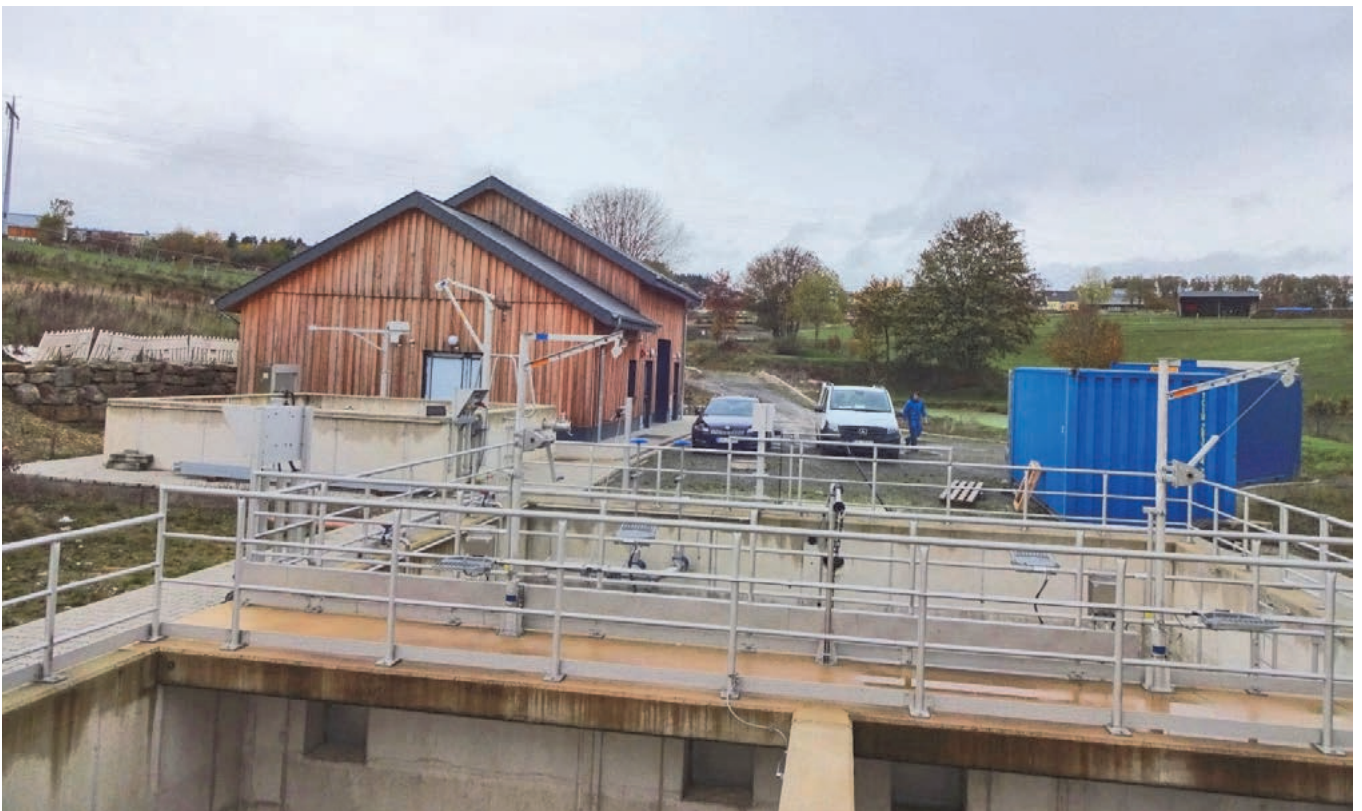
Photos: Station d'épuration à Hoscheid-Dickt 700 EH – Bassin biologique avec bâtiment technique en arrière-plan.
