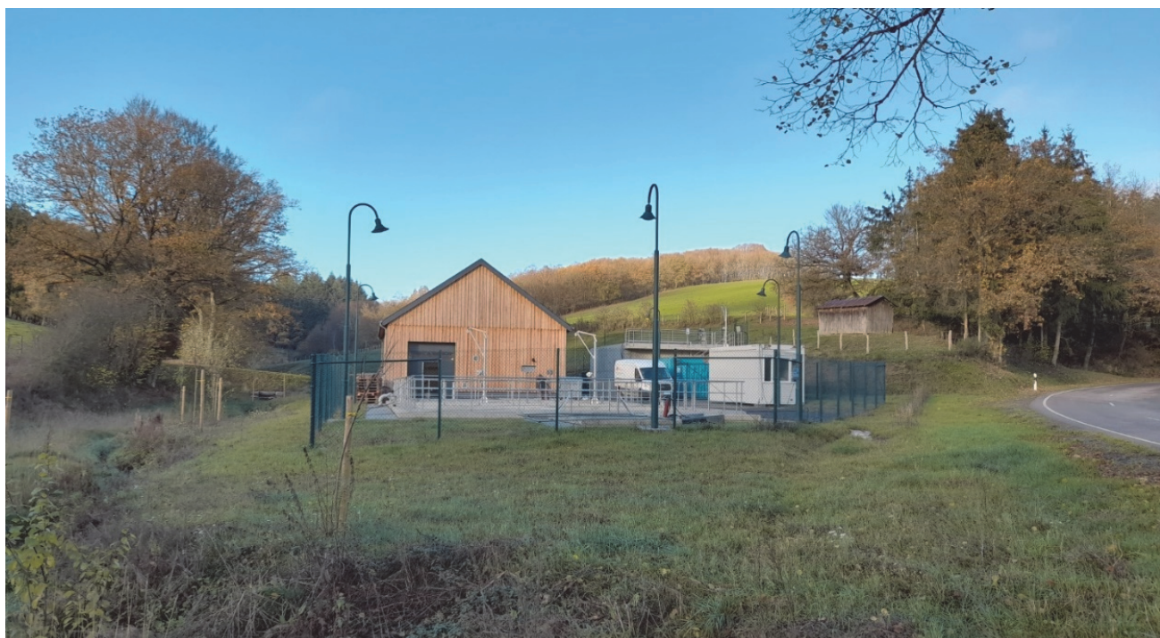
Photo: Station d'épuration à Brachtenbach 1.100 EH – vue d'ensemble des installations
