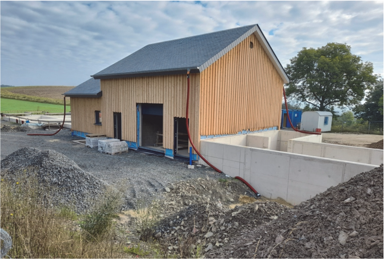
Photos: Station d'épuration à Putscheid 650 EH – Bâtiment de prétraitement et bassin d'orage en cours de réalisation
