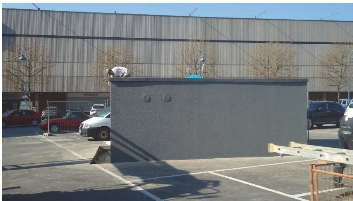
Photo: Local technique du bassin d'orage Monopol à Ettelbruck
