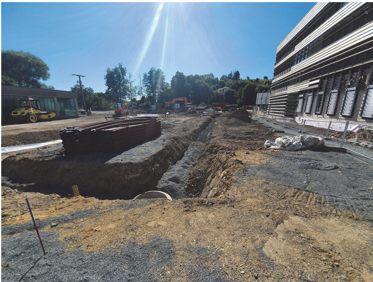
Photo: Chantier Bleesbruck Phase II + III – Travaux d'aménagements extérieurs
