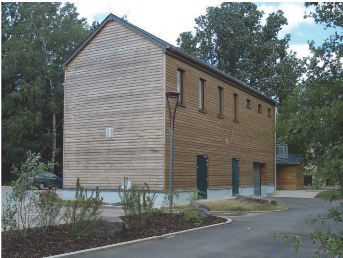
Photo: Bassin d'orage à Ettelbruck-sud
