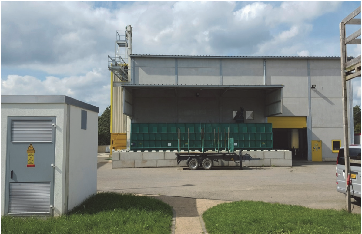
Hall des installations techniques d'ENERCOM et VALORTECH construit en 2012.
