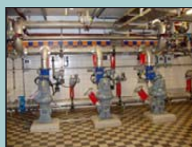
Kombianlag Feinreech, Sand a Fettfang (Kläranlag Ierpeldeng bei Wolz)
