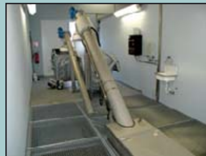
Kombianlag Feinreech, Sand a Fettfang (Kläranlag Ierpeldeng bei Wolz)
