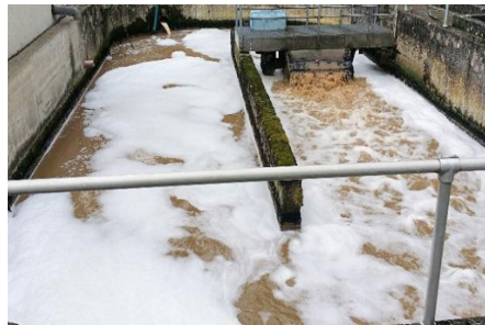
Développement de mousses sur le bassin d'activation suite à un déversement illicite / Schaumentwicklung im Belebungsbecken infolge eines unzulässigen Einleitens
