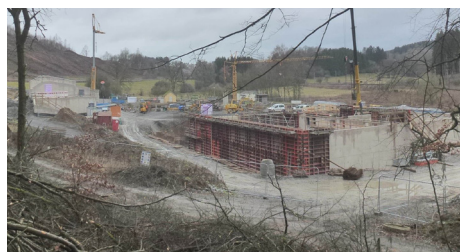
Vue sur le bâtiment technique à Troisvierges / Blick auf das Technikgebäude in Troisvierges
