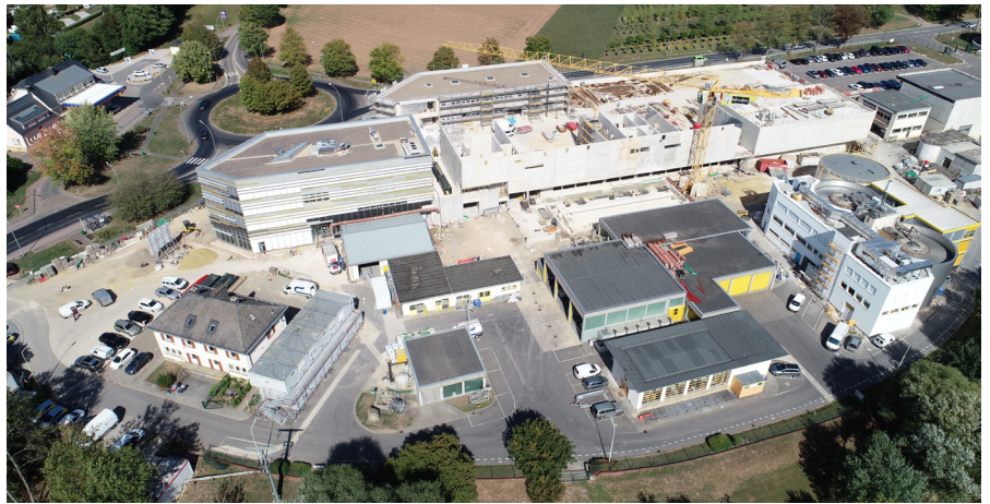
Vue aérienne de la station d'épuration de Blesbruck / Luftbild der Kläranlage Blesbruck
