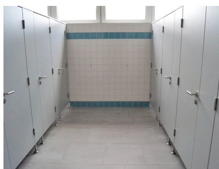
Salle de douche / Duschaum
