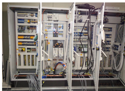
Armoire électrique en construction / Schaltschrank im Aufbau
