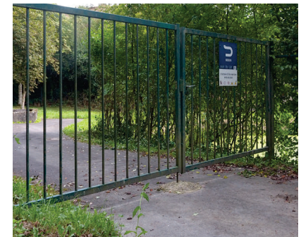
Zufahrtsbereich der Kläranlage
