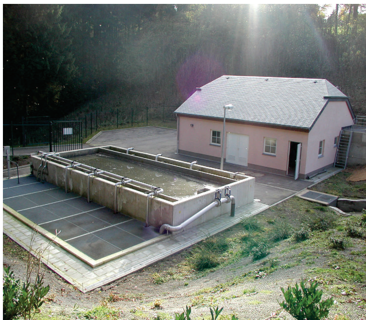
Gesamtansicht der Anlage
