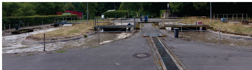
Oxydationsgraben der bestehenden Anlage
