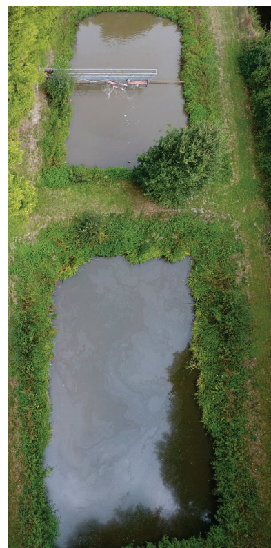
Luftaufnahme der Kläranlage
