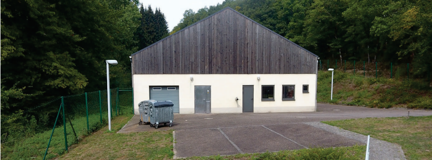
Eingangsbereich der Kläranlage
