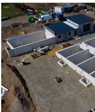
Betriebsgebäude mit Schlammstapelbehälter
