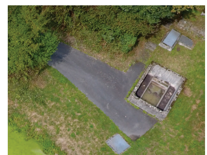
Mechanische Vorreinigung mittels Emscher-Grube
