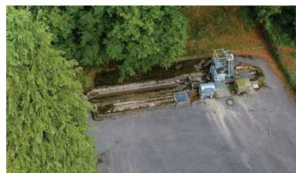
Luftansicht Sandfang und Grobrechen
