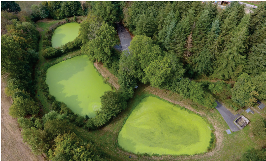
Luftaufnahme der bestehenden Kläranlage
