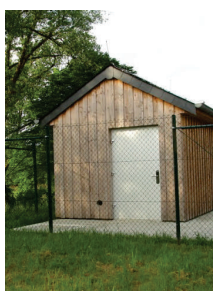
Technikgebäude Stauraumkanal Urspelt
