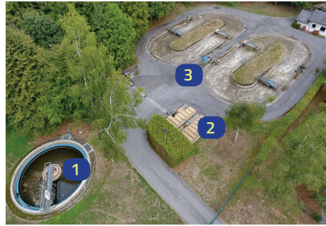
Nachklärbecken (1), Stabilisierungsbecken (2), Biologiebecken (3)
