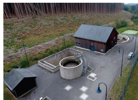
Einlaufbereiche der Kläranlage
