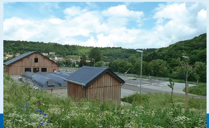
Betriebsgebäude / Schlammstilo / Biofilter
