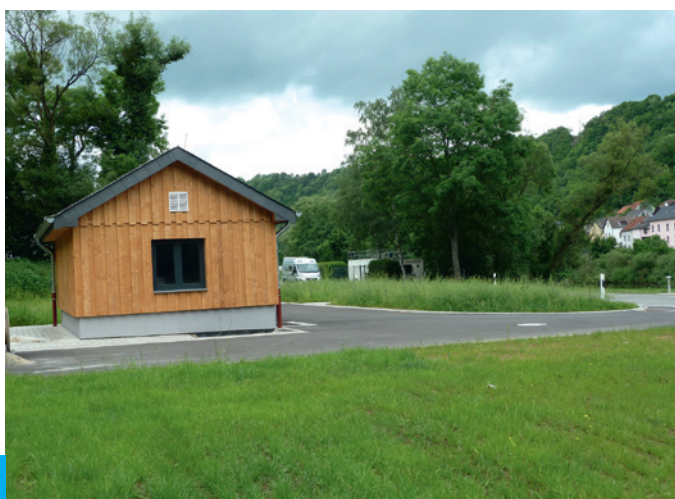
Pumpwerk & Regenüberlaufbecken | Betriebsgebäude
