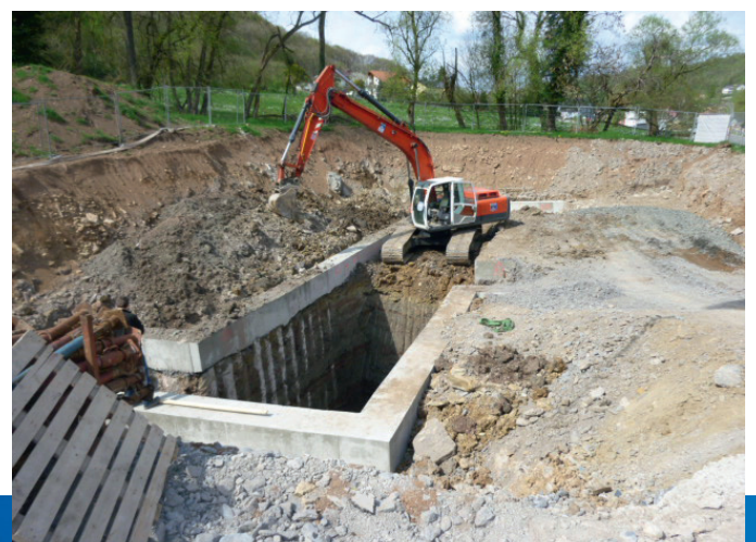
Pumpwerk & Regenüberlaufbecken | Bauphase
