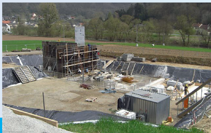
Biocos®-Becken / SU-Becken | Bauphase
