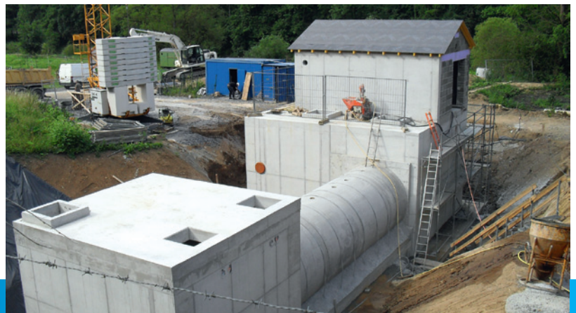
Pumpwerk & Regenüberlaufbecken | Bauphase
