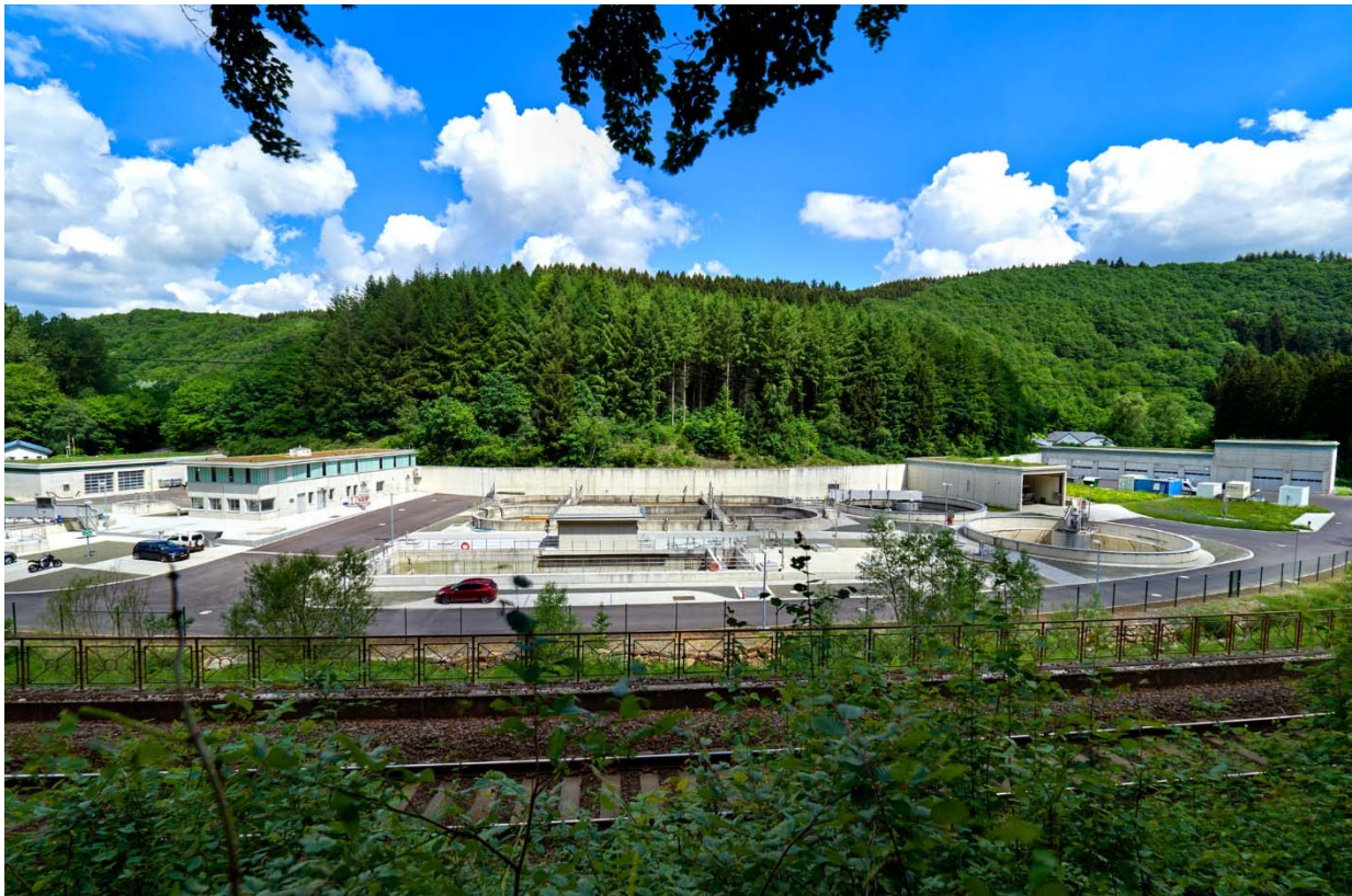
Vue sur la nouvelle station d'épuration à Wiltz
