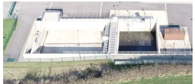
Vue aérienne du bassin d'orage
