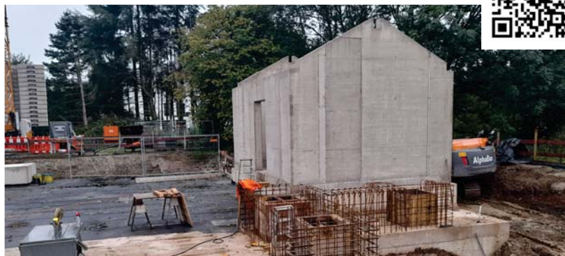
Vue extérieure du chantier
