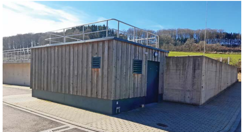
Vue extérieure sur le bassin d'orage
