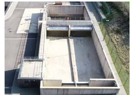
Vue aérienne du bassin d'orage
