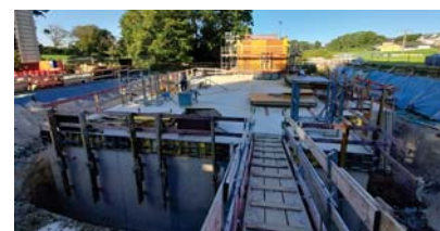
Vue extérieure du chantier
