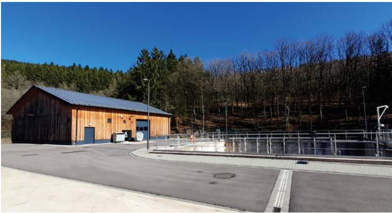
Vue extérieure de la station
