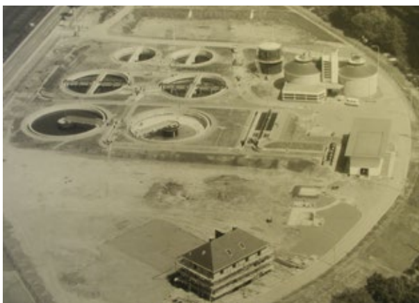
Anciens lits de déshydratation des boues en 1963 (fond d'image) / Ursprüngliche Vererdungsbecken aus dem Jahre 1963 (Oberer Bereich des Bildes)
