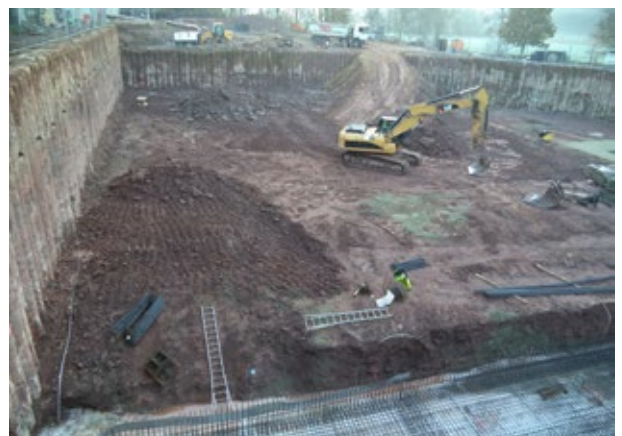
Blindage étanché en pieux sécants (novembre 2014) / Dichte Bohrfahlwand (November 2014)
