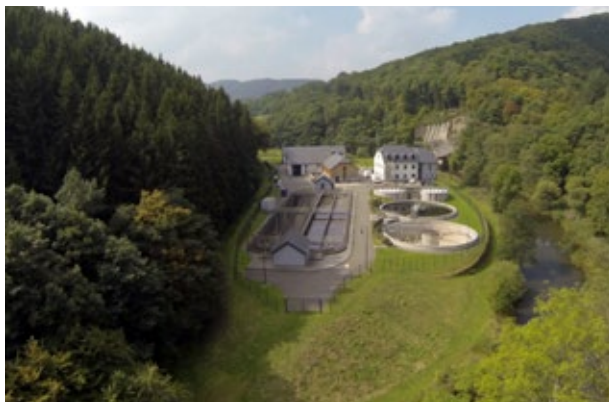
Vue aérienne de la station du Heiderscheidergrund / Die Kläranlage Heiderscheidergrund aus der Vogelperspektive
