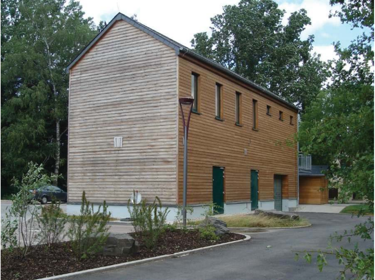
Photo : Bassin d'orage Ettelbruck-sud
