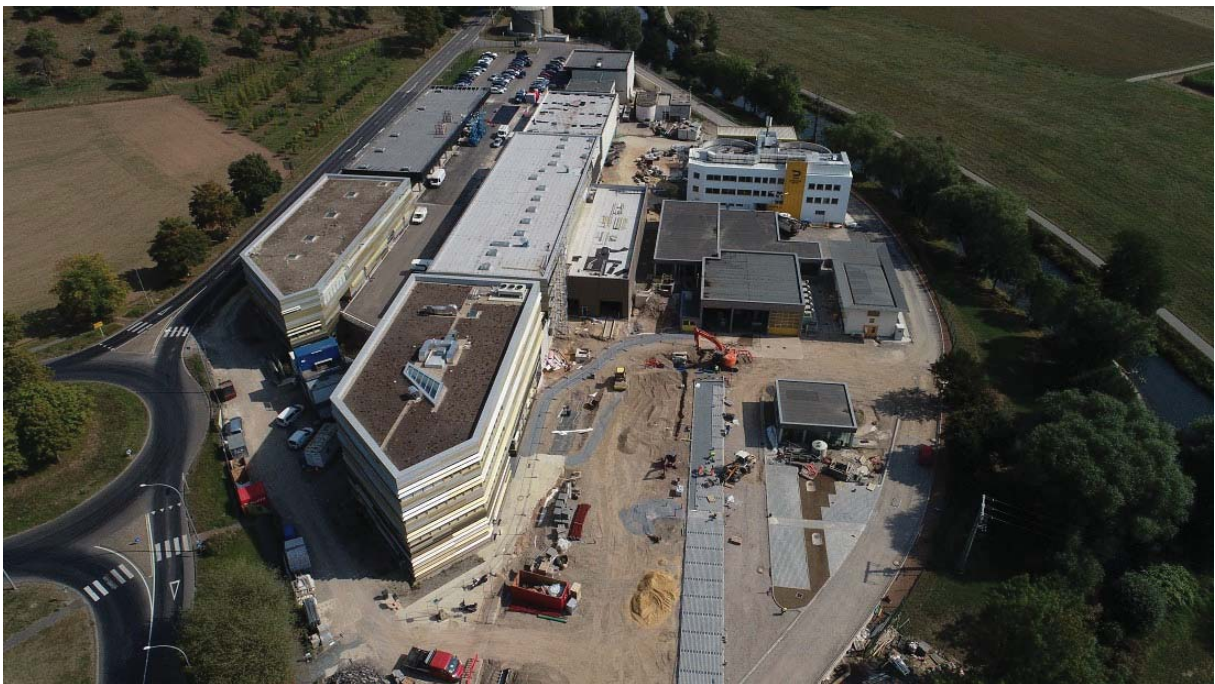
Photo : Chantier Blesbruck Phase III – Vue aérienne vers l'est
