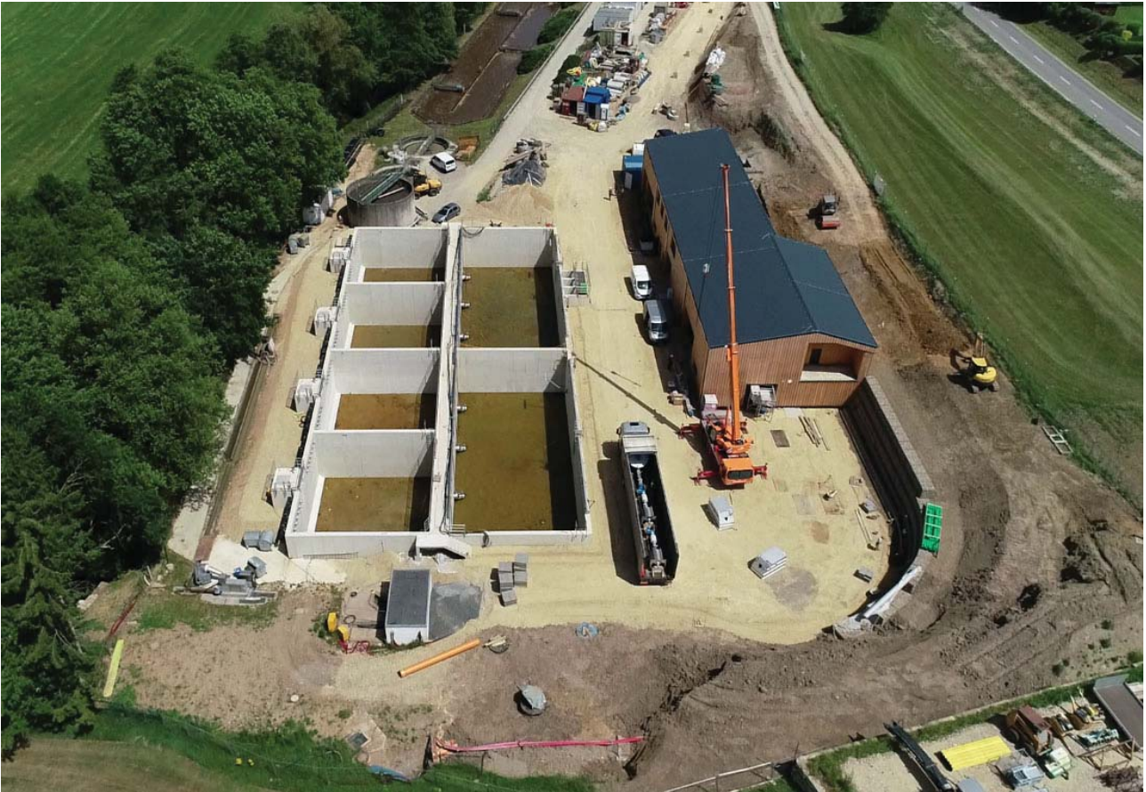
Photo : Station d'épuration à Medernach 13.000 EH - Voie de traitement biologique (phase 1) en cours d'équipement et bâtiment technique finalisé
