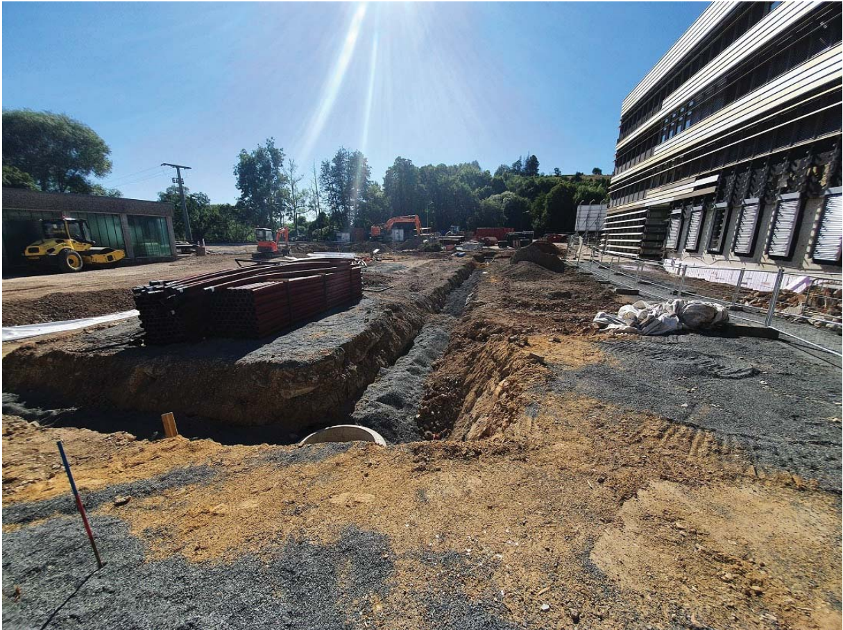
Photo : Chantier Blesbruck Phases II + III – Travaux d'aménagements extérieurs
