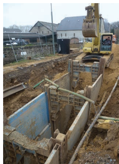
Pose des canalisations à Colbette
