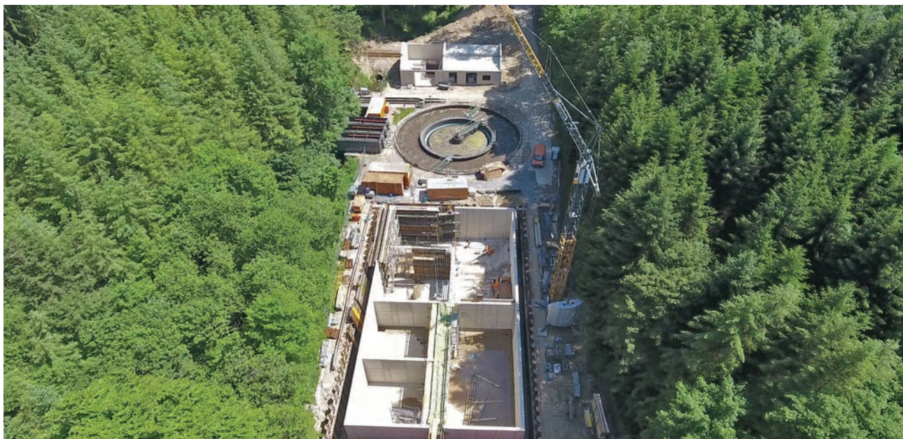
Vue aérienne du chantier de la nouvelle station.
