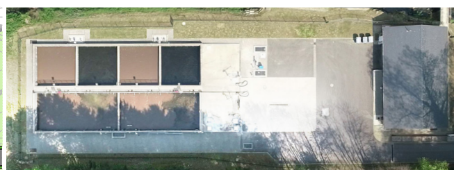
Vue aérienne de la station d'épuration
