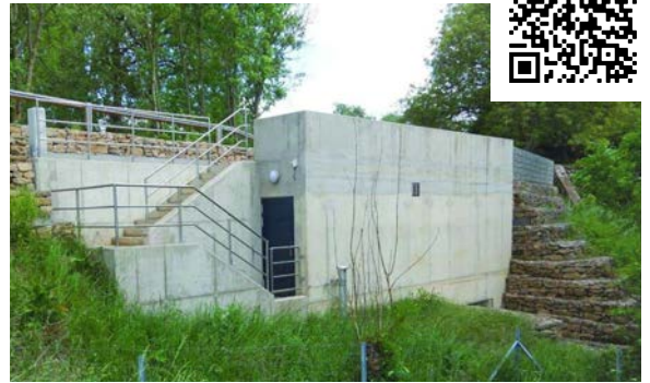
Vue extérieure sur le bâtiment de l'ouvrage
