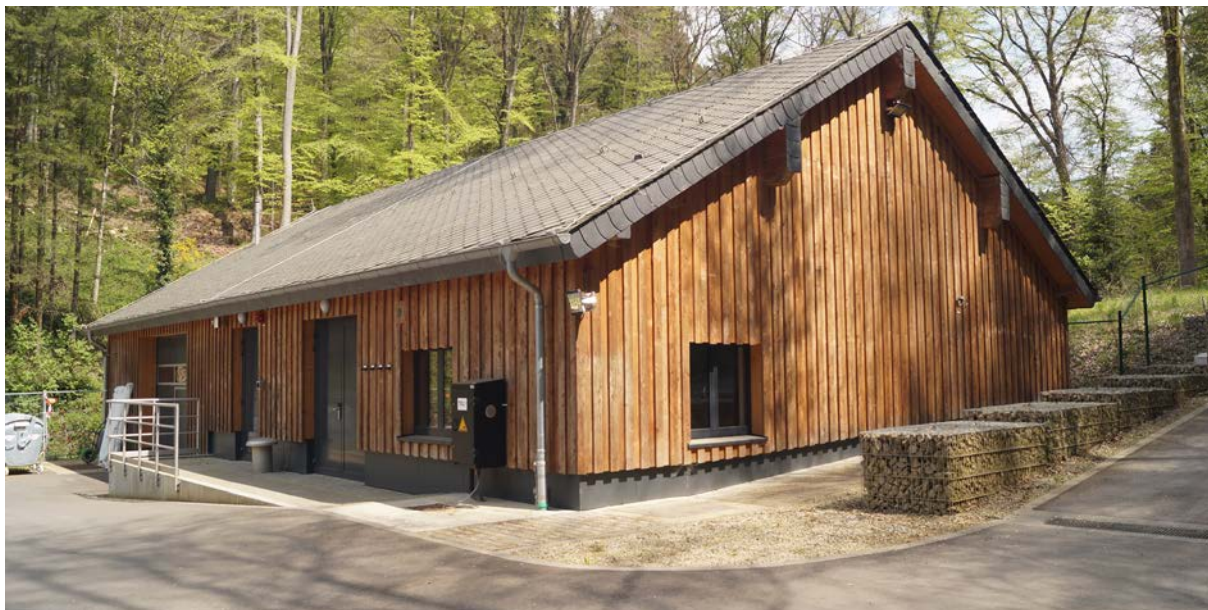
Vue sur le bâtiment de service
