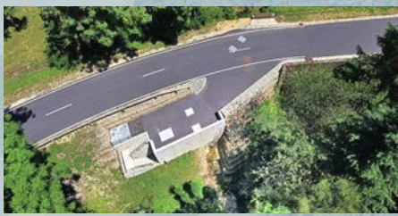
Bassin d'orage et station de pompage Colbette 10 m 3
