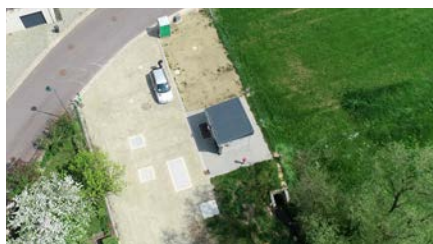
Vue aérienne sur l'emplacement du bassin d'orage « Biirsbach »
