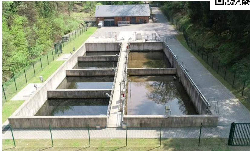
Vue générale sur la station d'épuration de Consdorf
