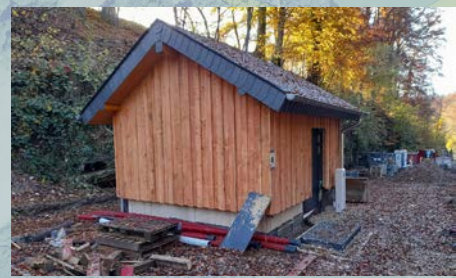
Bassin d'orage Riechenhaus 250 m 3
