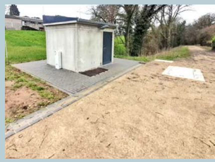
Bassin d'orage Biirsbaach 240 m 3
