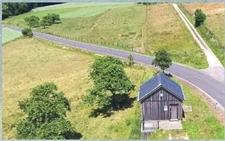
Bassin d'orage et station de pompage Breidweiler 150 m 3
