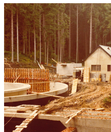
Chantier de la station historique de Consdorf
