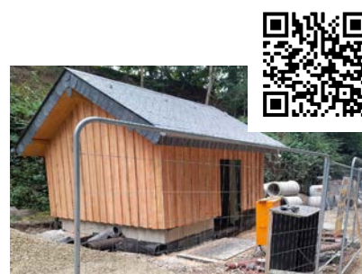
Vue sur le chantier du bassin d'orage « Riechenhaus »
