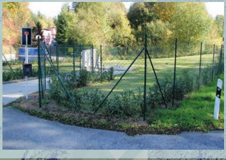
Bassin d'orage et station de pompage Scheidgen 150 m 3
