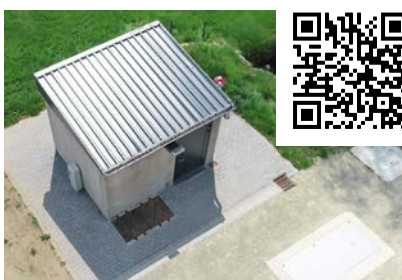
Vue sur le bâtiment de service du bassin d'orage « Biirsbach »
