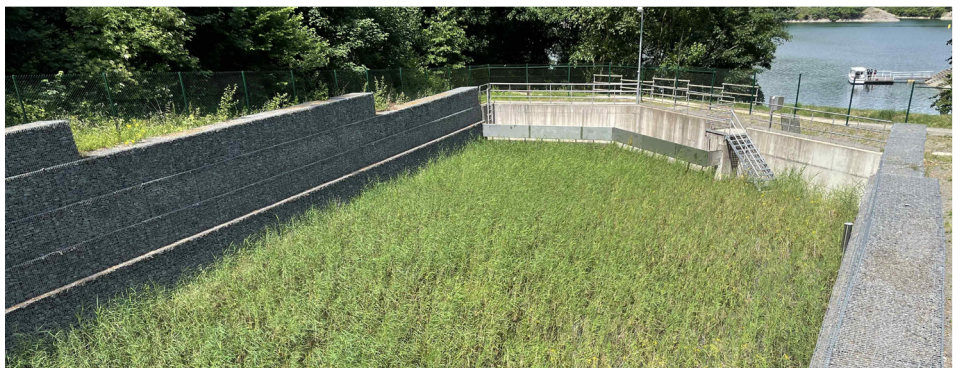
Bassin de rétention et de filtration à Insenborn / Retentionsbodenfilter in Insenborn
