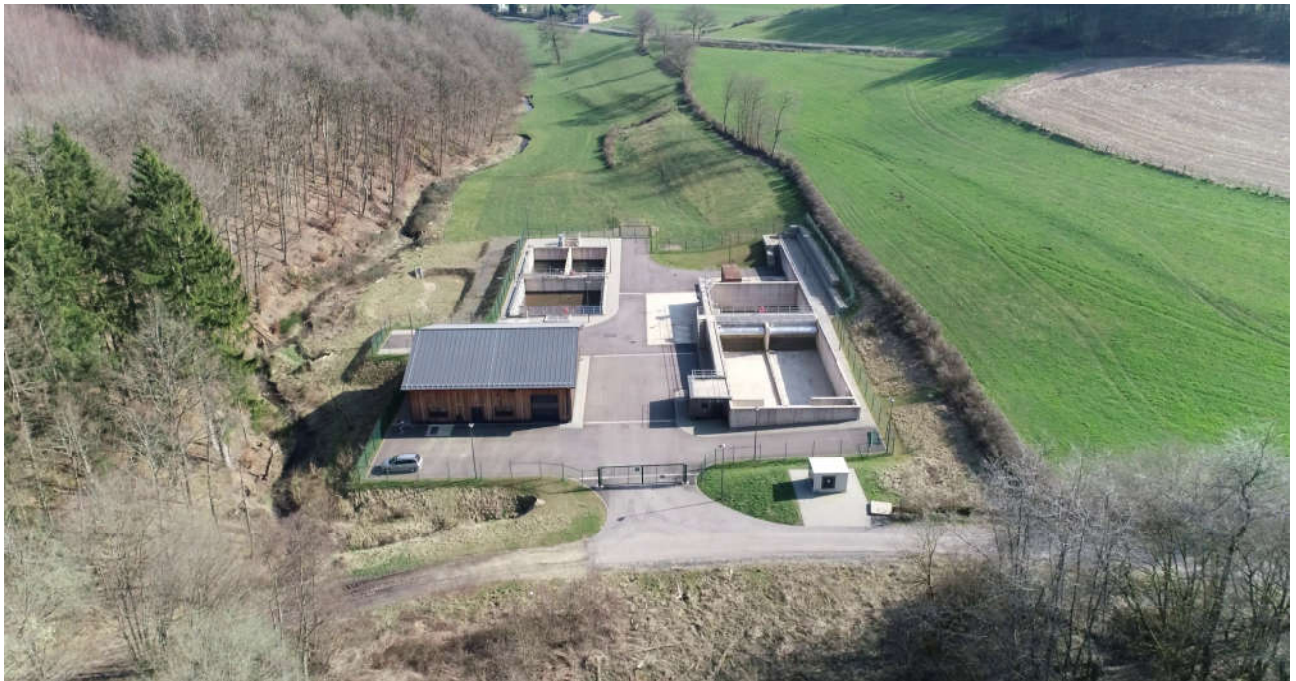
« Vue aérienne sur la station d'épuration à Folschette »
