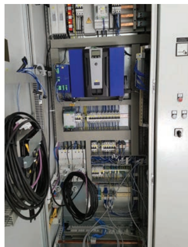
Armoire électrique en montage
