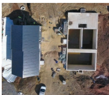
Vue aérienne de la station en chantier
