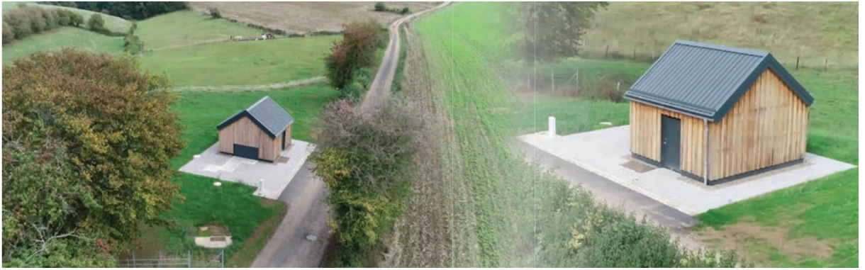
Vue aérienne sur le site environnant de la station d'épuration
