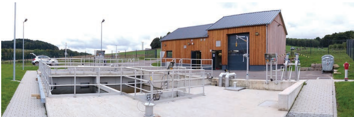
Vue panoramique de la station d'épuration de Buschrodt
