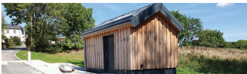
Local technique du bassin d'orage Wahl-Faubourg
