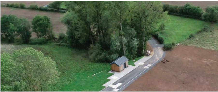
Vue aérienne sur le site environnant du bassin d'orage
