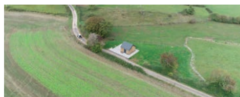
Vue aérienne sur la station de pompage de Wahl-Heckewee
