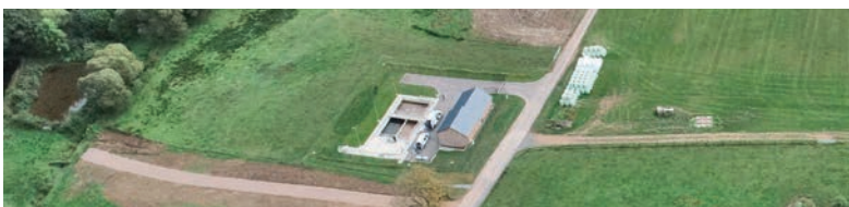
Vue aérienne sur la station d'épuration de Buschrodt
