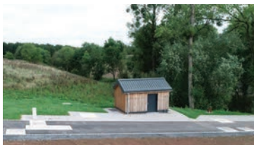
Vue d'ensemble du bassin d'orage
