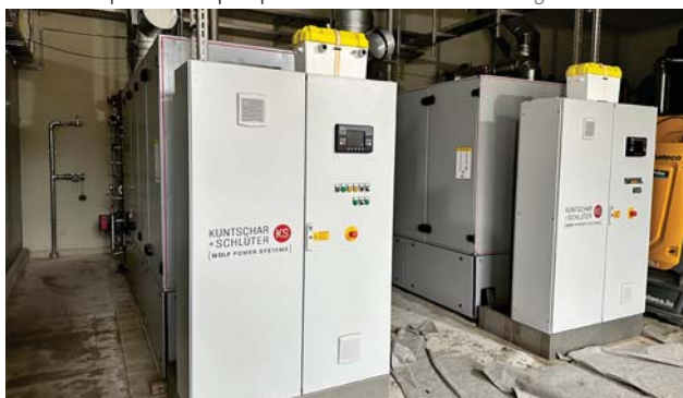
Installation de deux cogénérations / Installation von zwei Blockheizkraftwerken
