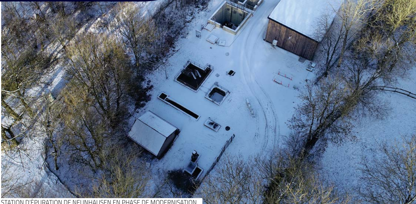
STATION D'ÉPURATION DE NEUNHAUSEN EN PHASE DE MODERNISATION
