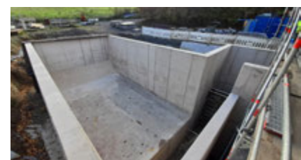
Regenüberlaufbecken im Rohbau
