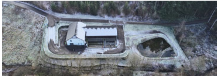
Luftbild der Kläranlage Hosingen
