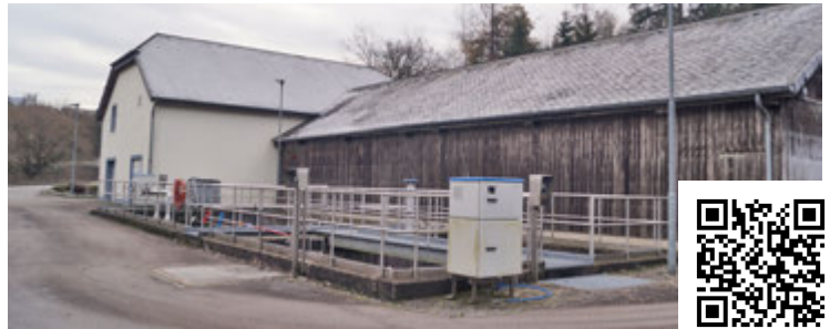
Aussenansicht Kläranlage Hosingen (Innenhof)
