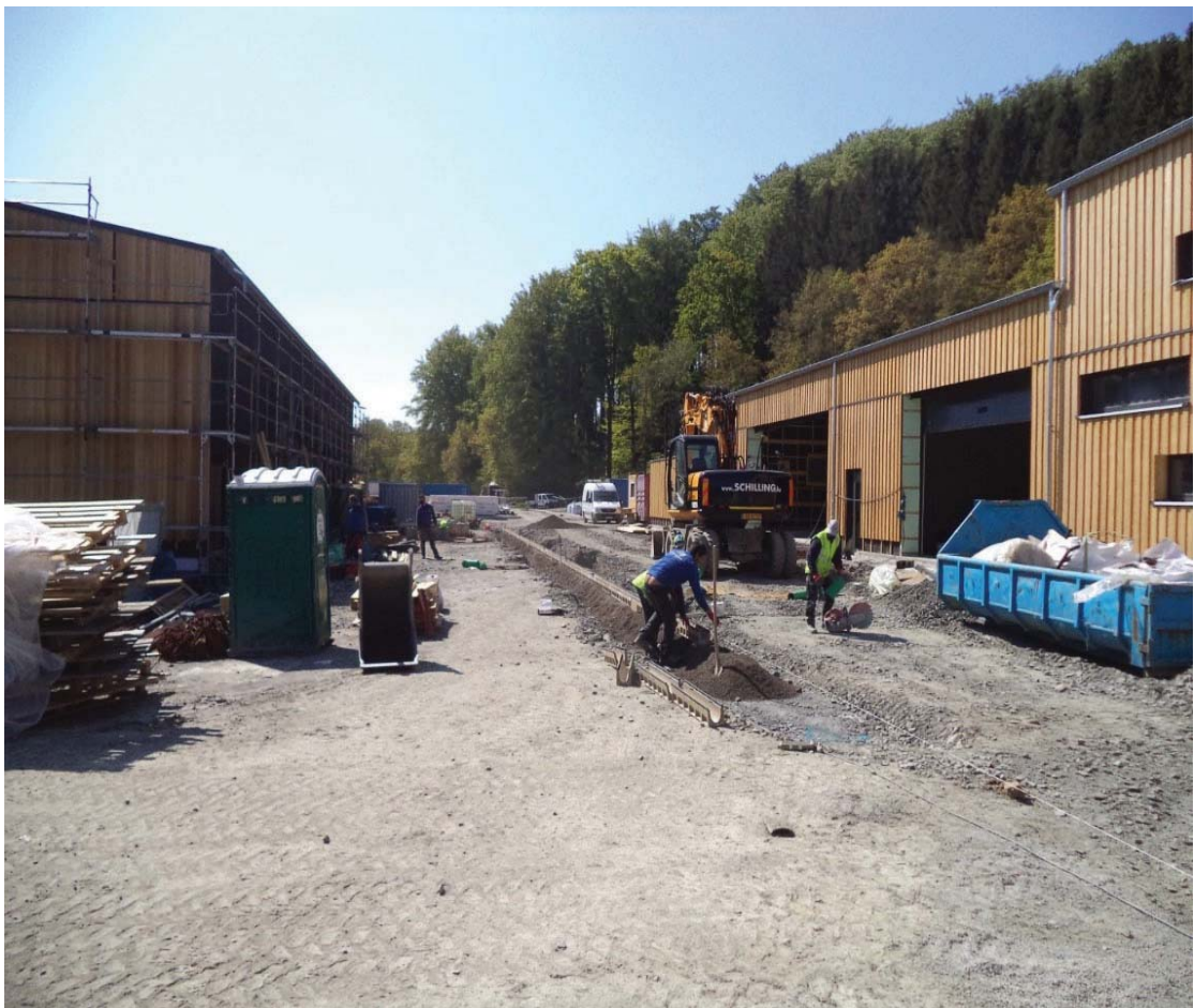
Photos: Station d'épuration à Troisvierges 8.400 EH - Bâtiment technique en cours de réalisation
