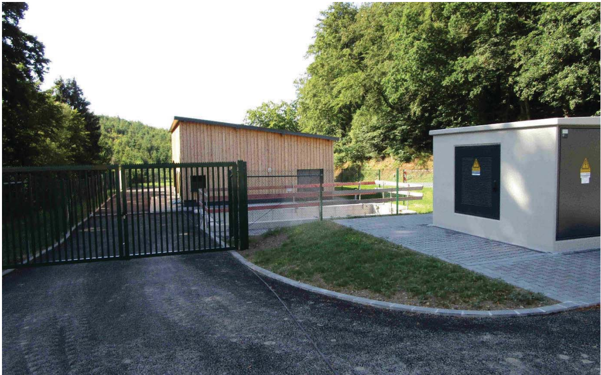
Photo: Station d'épuration à Beiler 350 EH - vue d'ensemble des installations
