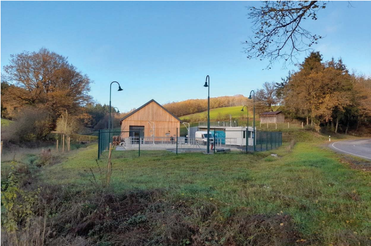
Photo: Station d'épuration à Brachtenbach 1.100 EH – vue d'ensemble des installations
