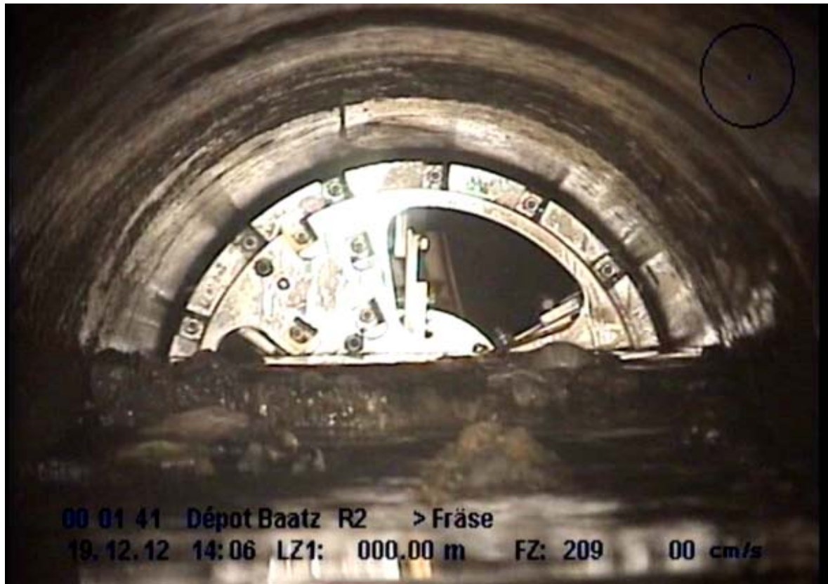
Photo: Vue télévisée de contrôle d'un procédé de fraisage d'une conduite obturée
