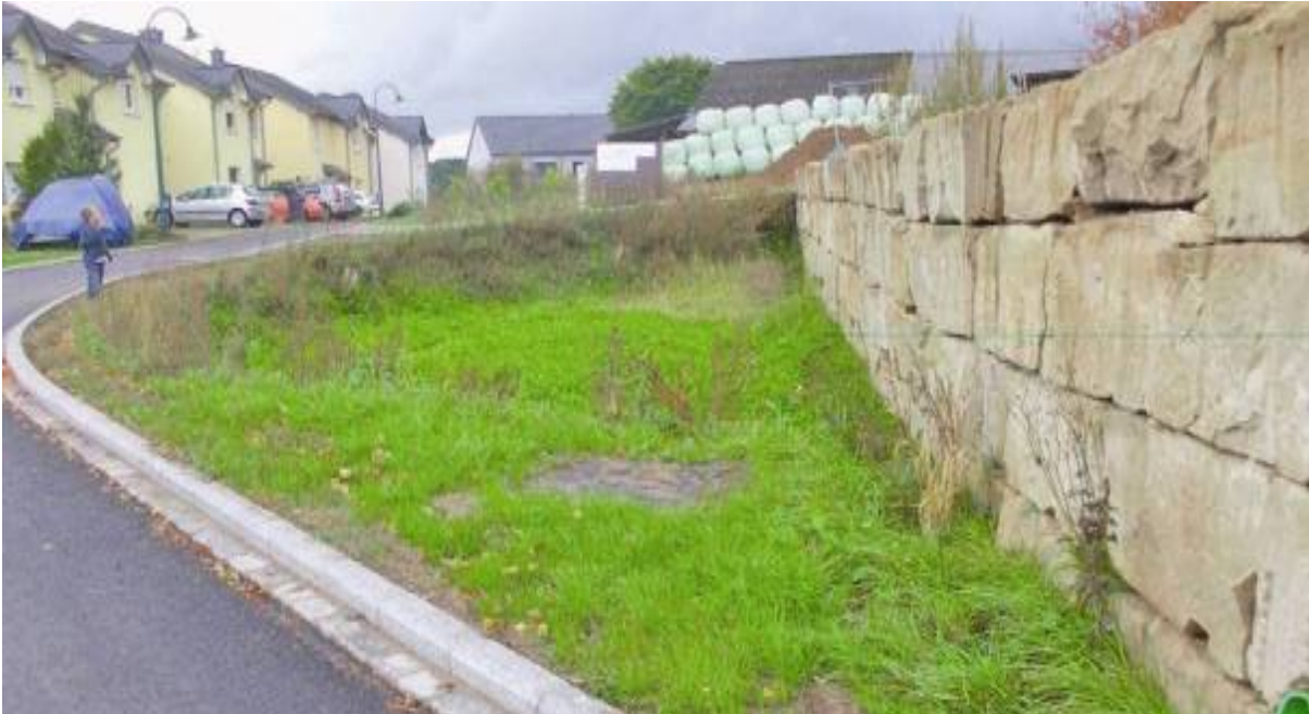
Photo: Mauvais exemple d'une rétention décentralisée
