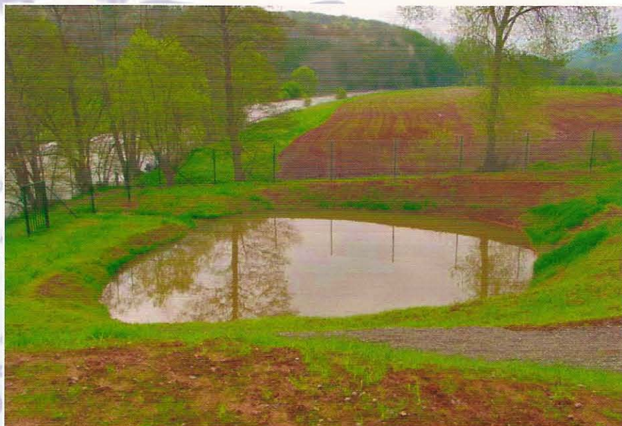
◀ Versickerungs- mulde der Anlage
