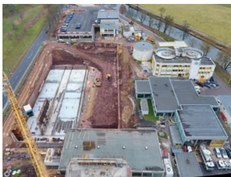
Emplacement des bassins d'aération après terrassement Standort der neuen Belebungsbecken nach Aushub
