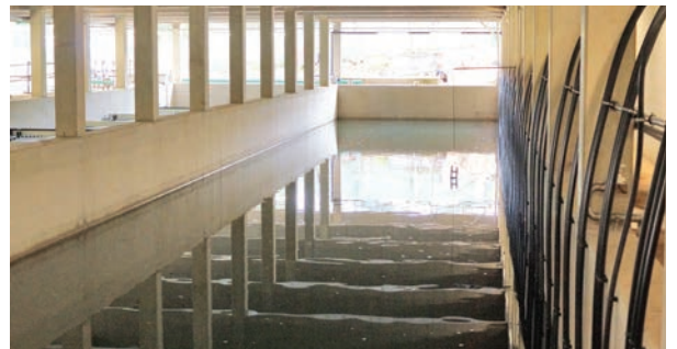
Bassin d'aération temporaire en eau et fonctionnel Provisorisches Belebungsbecken gefüllt und in Betrieb
