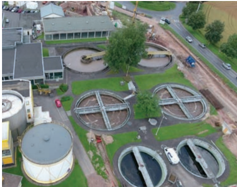
Emplacement des bassins d'aération avant terrassement Standort der neuen Belebungsbecken vor Aushub
