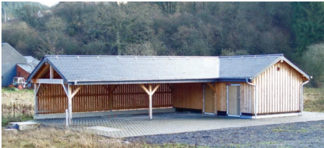
Bassin d'orage / Regenüberlaufbecken
