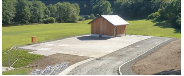
Bassin d'orage 1 / Regenüberlaufbecken 1
