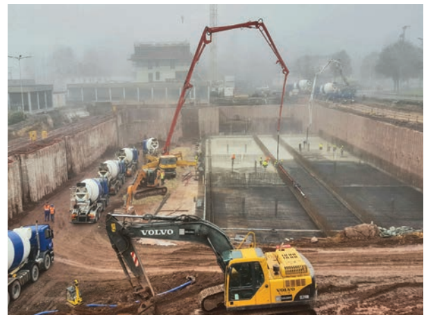
Bétonnage du radier de la biologie (décembre 2016) Betonierarbeiten der Bodenplatte des Biologiebeckens (Dezember 2016)
