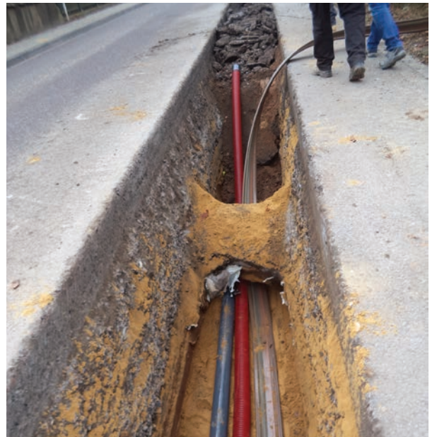
Pose du Flatliner et de la conduite d'eau / Verlegen des Flatliners und der Wasserleitung
