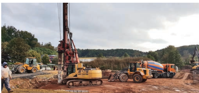
Forage des pieux du bassin d'orage / Herstellung von Bohrpfehlen für den Bau des Beckens (RÜB)
