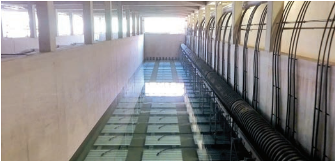
Bassin d'aération temporaire en cours de remplissage Provisorisches Belebungsbecken wird mit Klarwasser gefüllt
