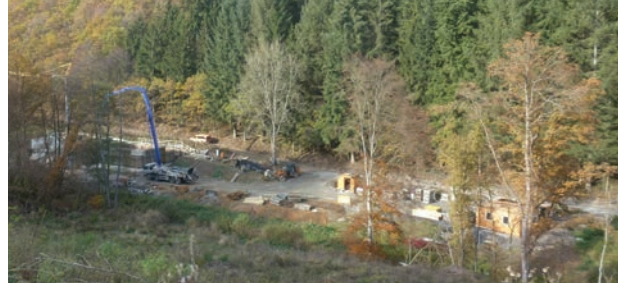
Chantier Station d'épuration biologique 450 EH Baustelle biologische Kläranlage 450 EW
