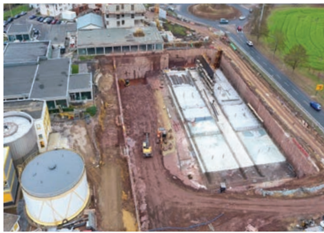
Emplacement des bassins d'aération après terrassement Standort der neuen Belebungsbecken nach Aushub
