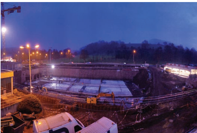
Bétonnage du radier de la biologie (décembre 2016) Betonierarbeiten der Bodenplatte des Biologiebeckens (Dezember 2016)
