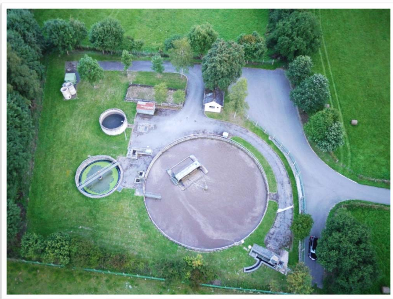
Vue aérienne du site de la future station d'épuration à Troisvierges
