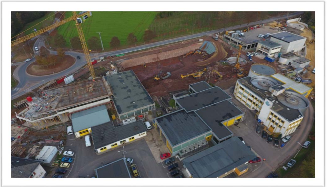
Vue aérienne du chantier de Blesbruck – Phases 2 & 3
