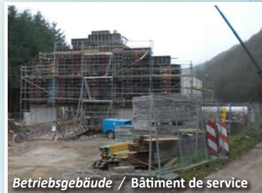
Betriebsgebäude / Bâtiment de service
