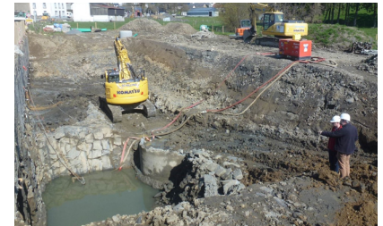
Aushubarbeiten Rüb Troine
