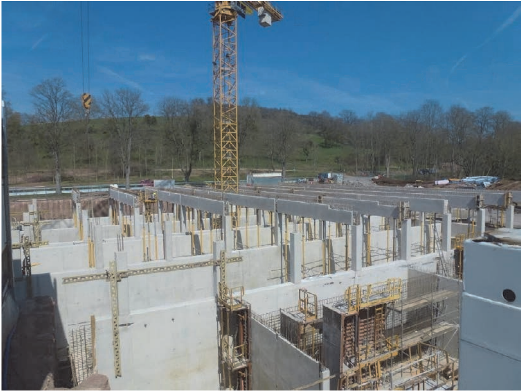
Photo: Chantier Bleesbruck Phase I
