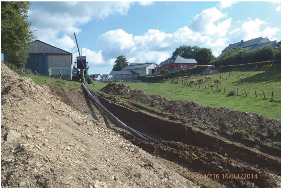
Photo: Pose d'un collecteur par trancheuse-charrue (Chantier Hupperdange)
