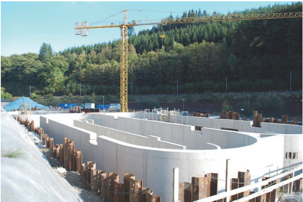
Photo: Station d'épuration à Wiltz
