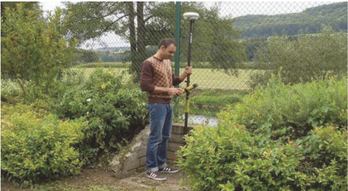
Photo: Levé topographique du terrain par GPS
