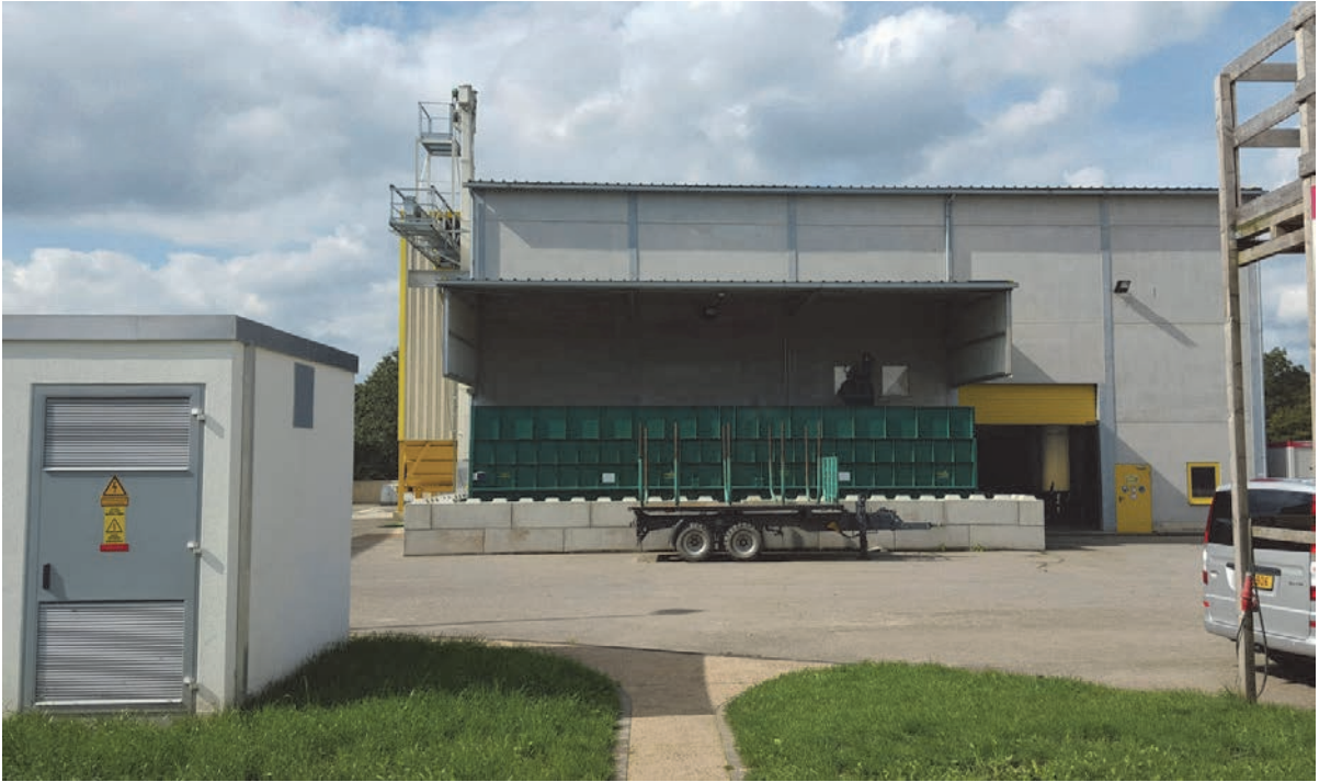
Fig 2: Hall des installations techniques d'ENERCOM et VALORTECH construit en 2012.
