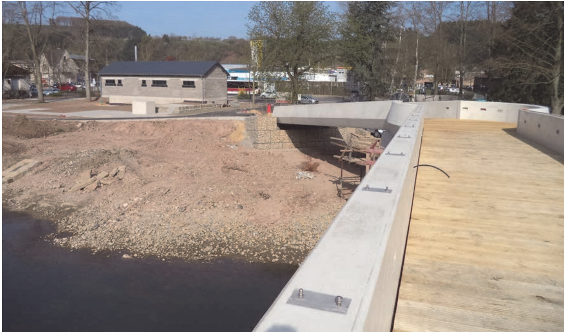
Photo: Bassin d'orage Diekirch V
