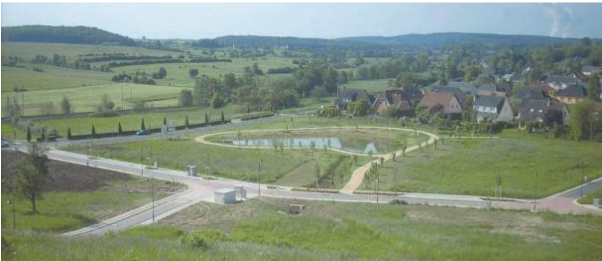
Photo: Bon exemple d'une rétention centralisée (RE-GE-BIO)
