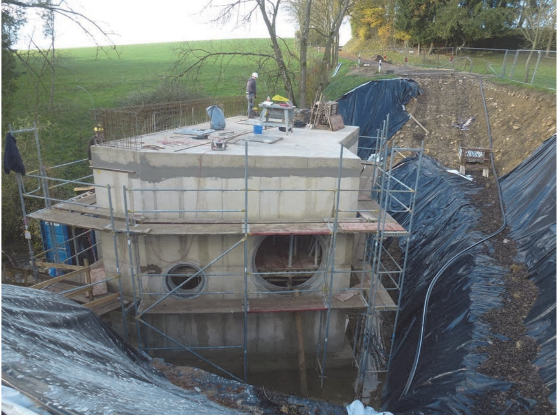
Photo: Bassin d'orage à Colbette
