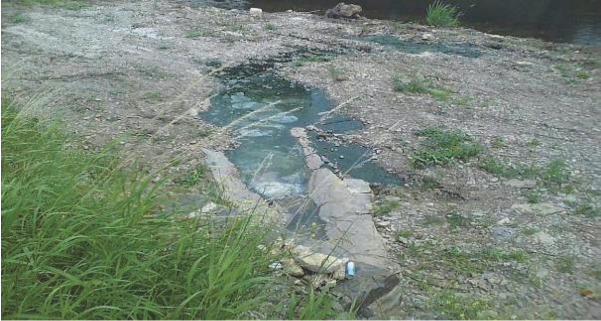
Photo: Rejet d'eau usée dans le milieu naturel à Ingeldorf suite à une erreur de branchement
