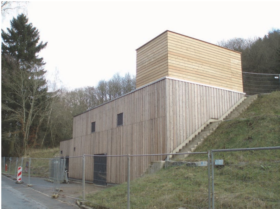
Photo: Station de pompage à Lultzhausen
