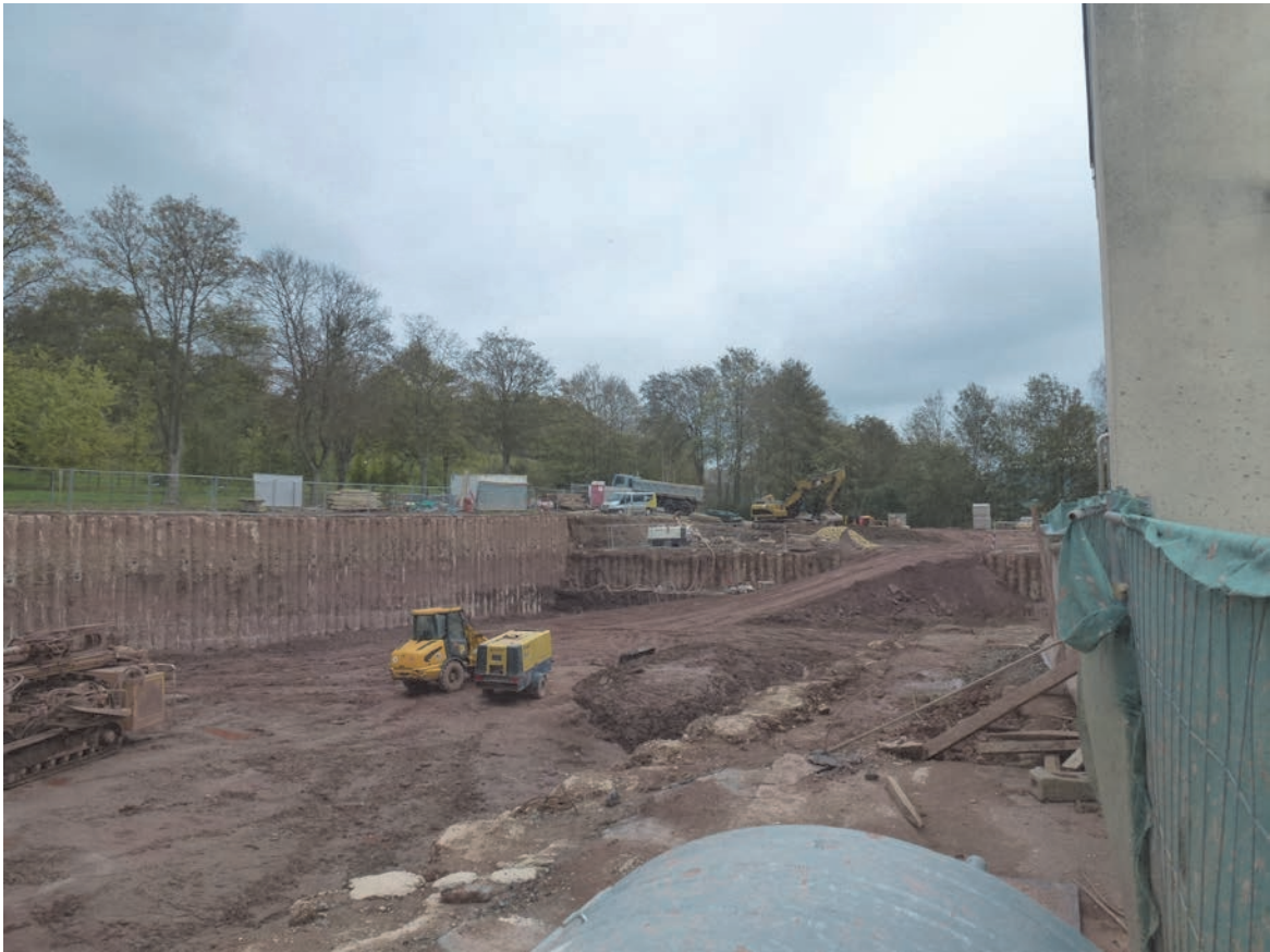
Photo: Terrassement Chantier Bleesbruck Phase I
