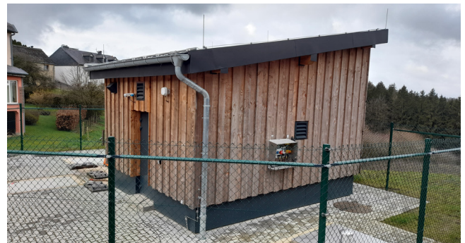
Bassin d'orage avec station de pompage Holtz 1
