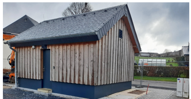
Bassin d'orage avec station de pompage Holtz 2
