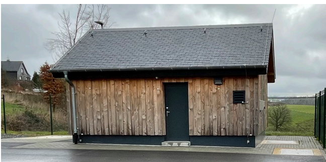
Bassin d'orage avec station de pompage Perlé-Football (Perlé 1)
