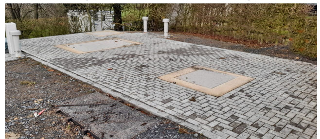
Station de pompage Holtz 3 (pendant les travaux)
