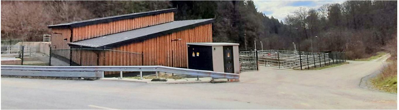
Vue sur l'entrée de la station d'épuration
