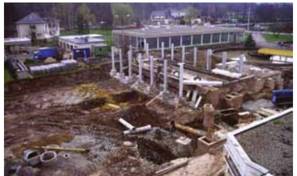
Komplettmassnahme: Umbau Grobrechen – Sandfang, Fahrzeugatelier und Garagen (um 1990)
