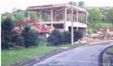
Bau des Schlammwässerungsgebäudes (um 1975)
