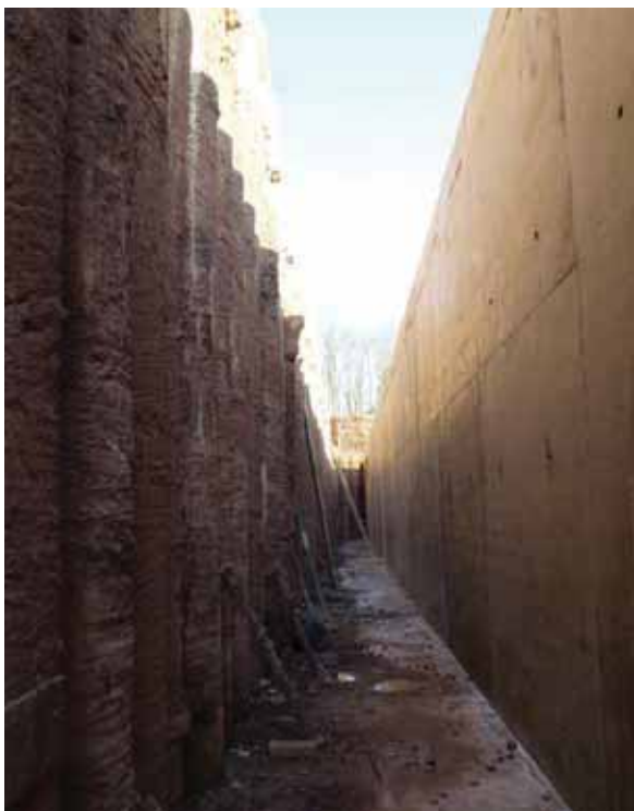
Zwischenraum Bohrpfehlwand – Außenwand Nachklärung
