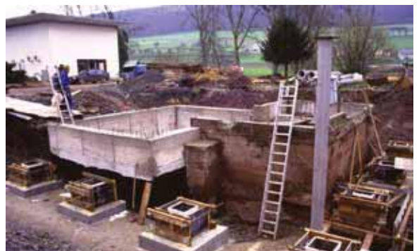
Umbau Grobrechen (um 1990)
