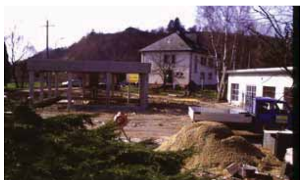
Hochbauteil Grobrechen (um 1990)
