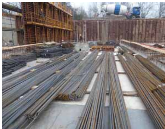
Bewehrungsarbeiten an der Bodenplatte
