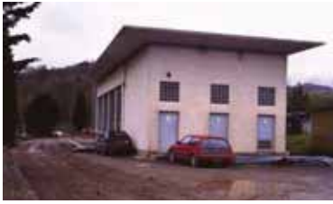
Pumpenhaus, Gebläsestation und Trafogebäude (Umbau 1980)
