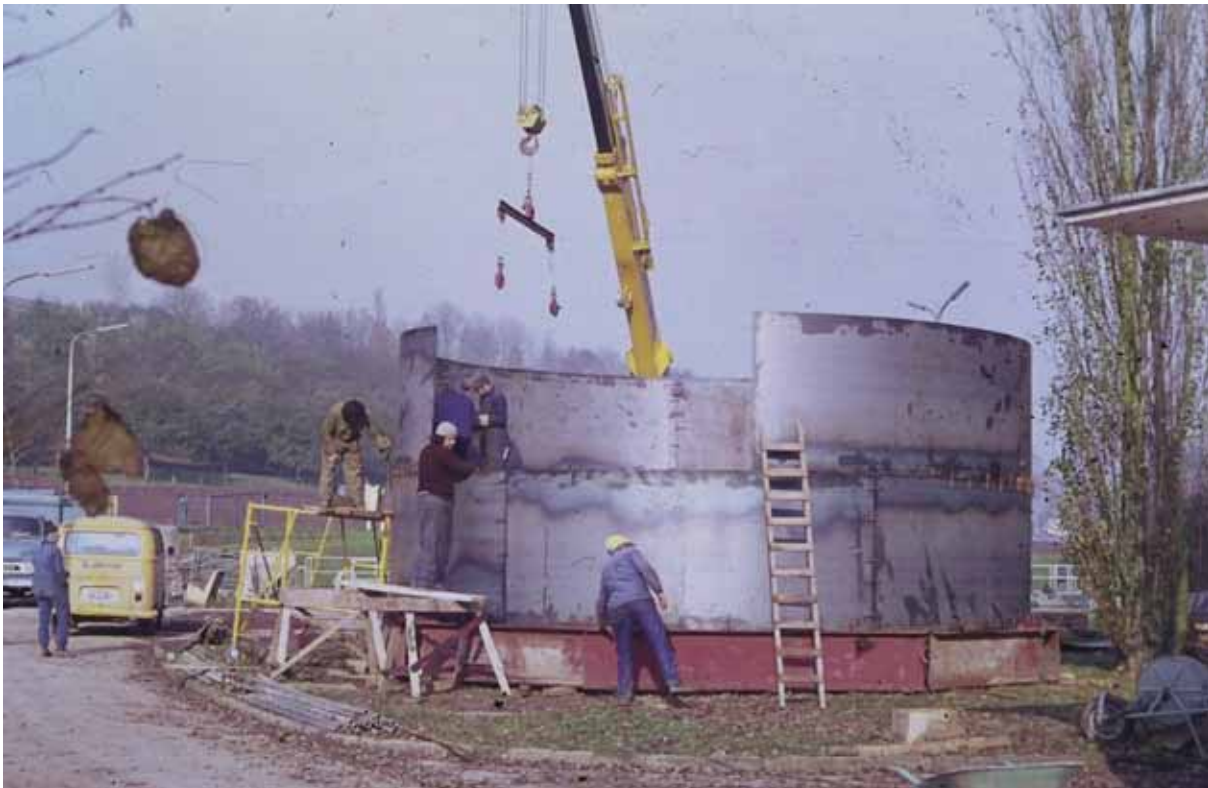
Errichten des 1sten Gasbehälters (um 1975)
