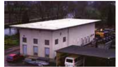
Pumpenhaus, Gebläsestation und Trafogebäude mit Hangar (um 1990)
