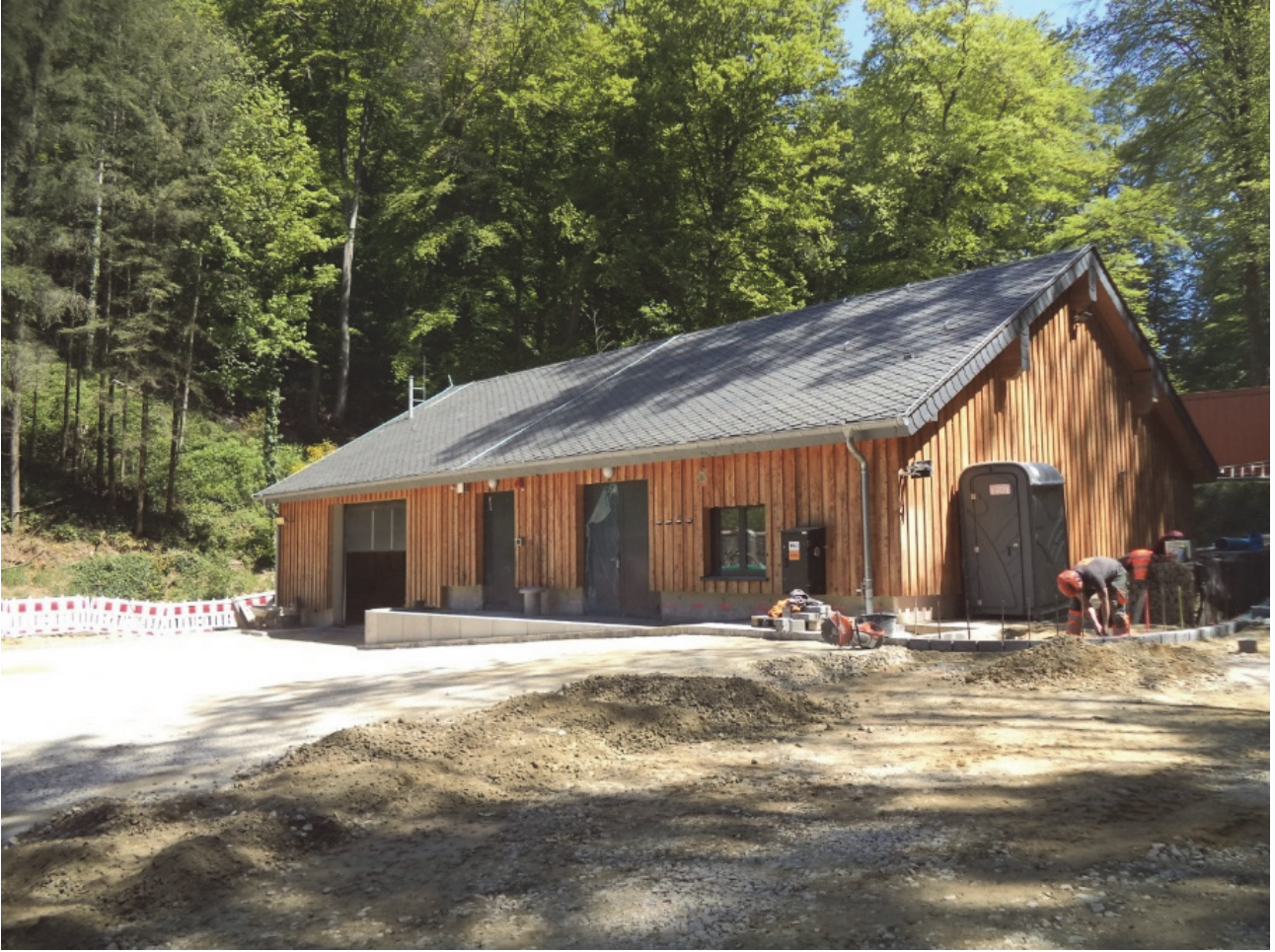
Photo: Station d'épuration à Consdorf 4.000 EH - bâtiment technique en cours d'équipement
