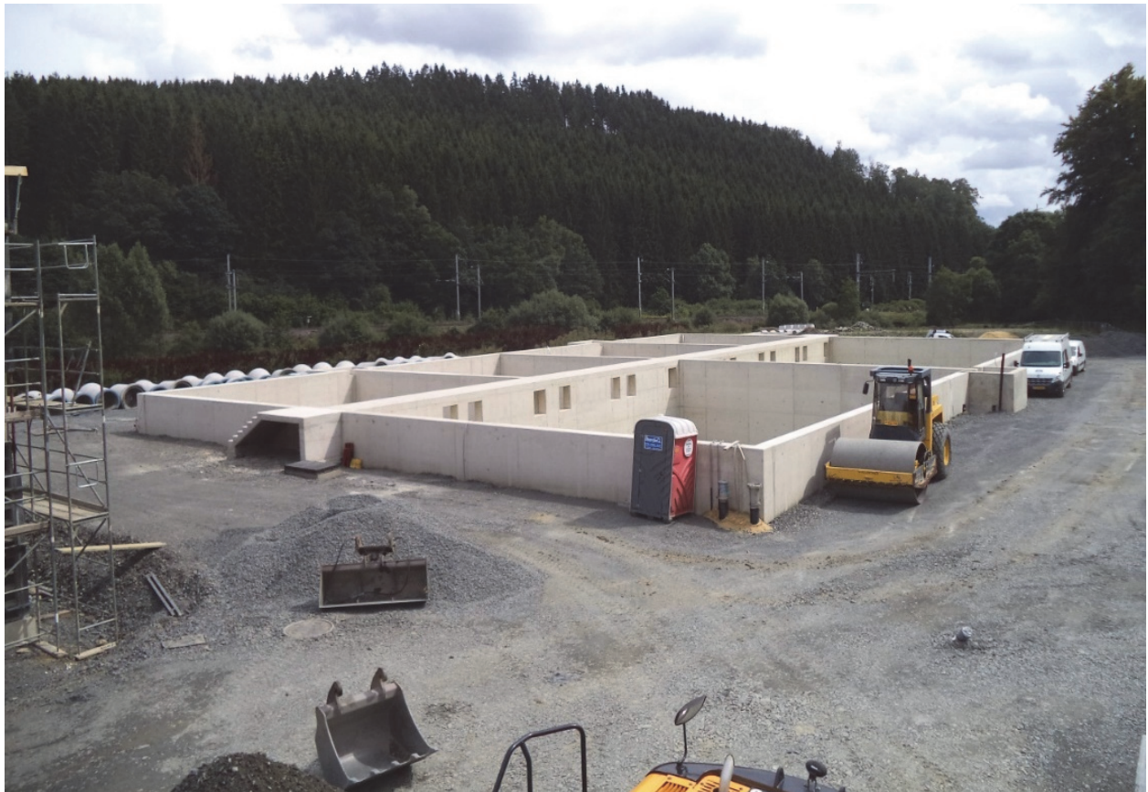
Photos: Station d'épuration à Troisvierges 8.400 EH Voie de traitement biologique et bâtiment technique en cours de réalisation
