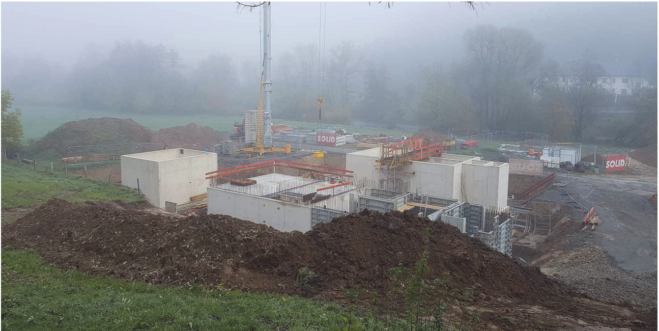
Photo: Travaux de gros-oeuvre à la station d'épuration de Hoesdorf – 300 EH
