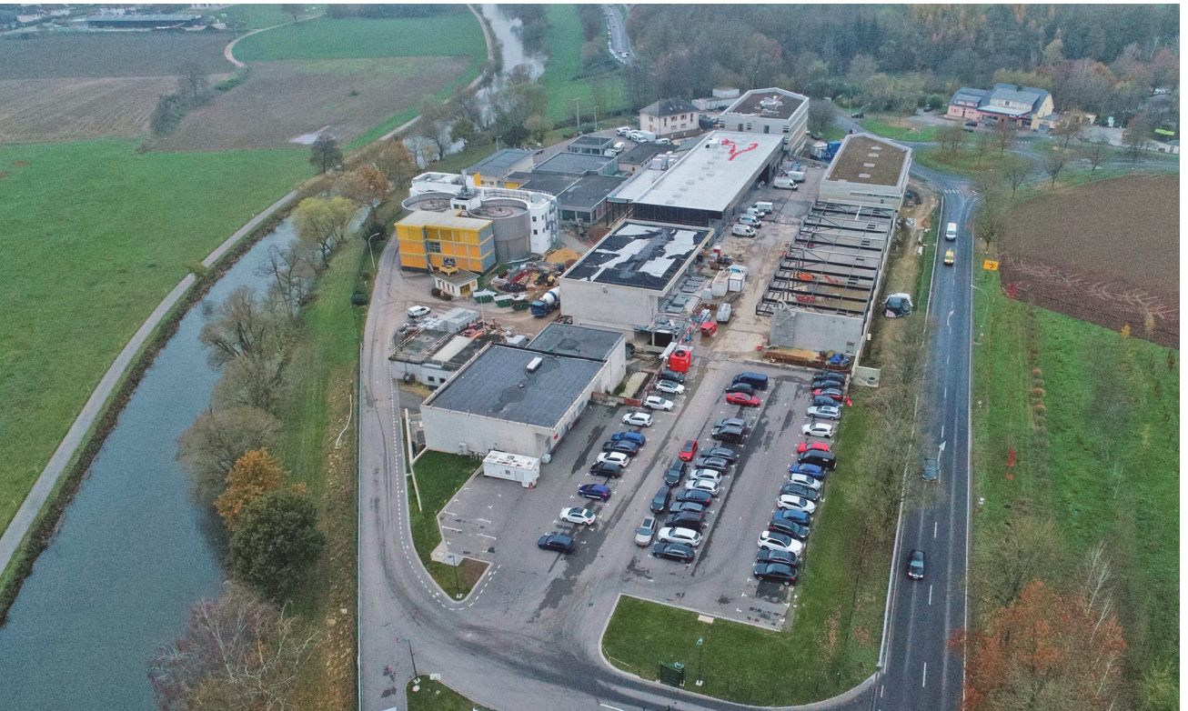
Photo: Chantier Blesbruck Phase II + III – Vue aérienne vers l'ouest
