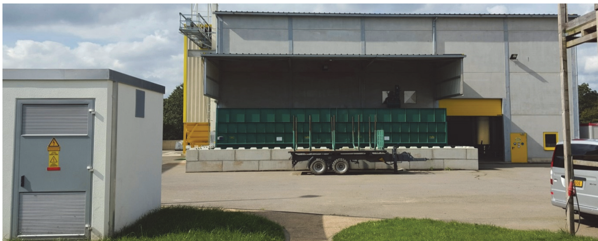
Hall des installations techniques d'ENERCOM et VALORTECH construit en 2012.
