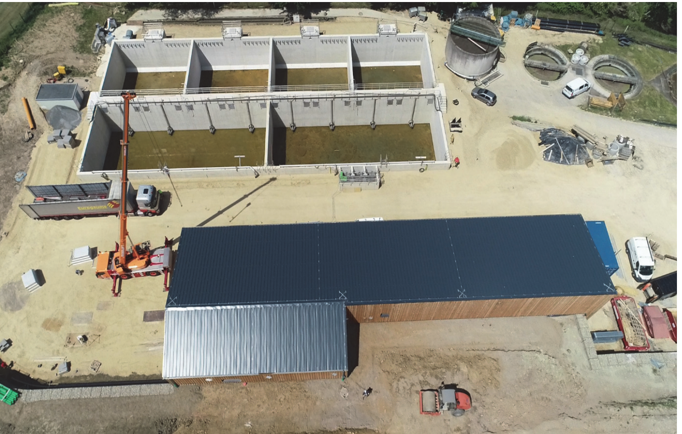
Photos: Station d'épuration à Medernach 13.000 EH Voie de traitement biologique (phase 1) en cours d'équipement et bâtiment technique finalisé
