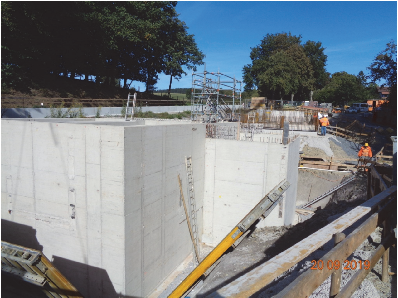
Photo: Travaux de bétonnage de la voie de traitement biologique à Beiler – 350 EH
