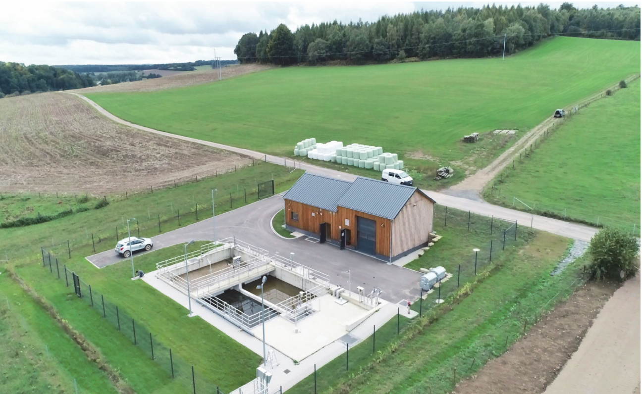
Photo: Mise en service de la station d'épuration à Buschrodt – 800 EH
