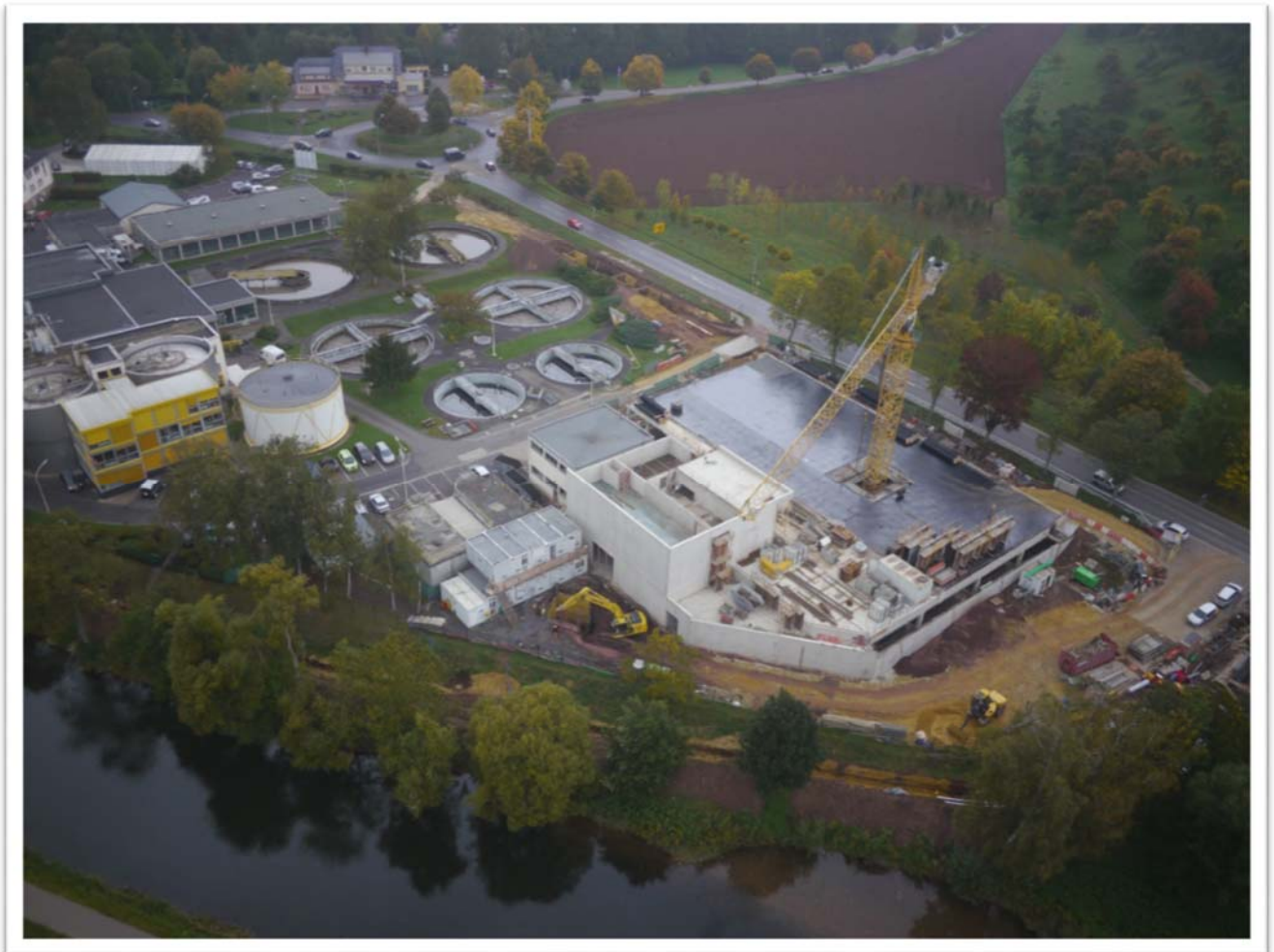
Vue aérienne du chantier de Bleesbruck – Phase I
