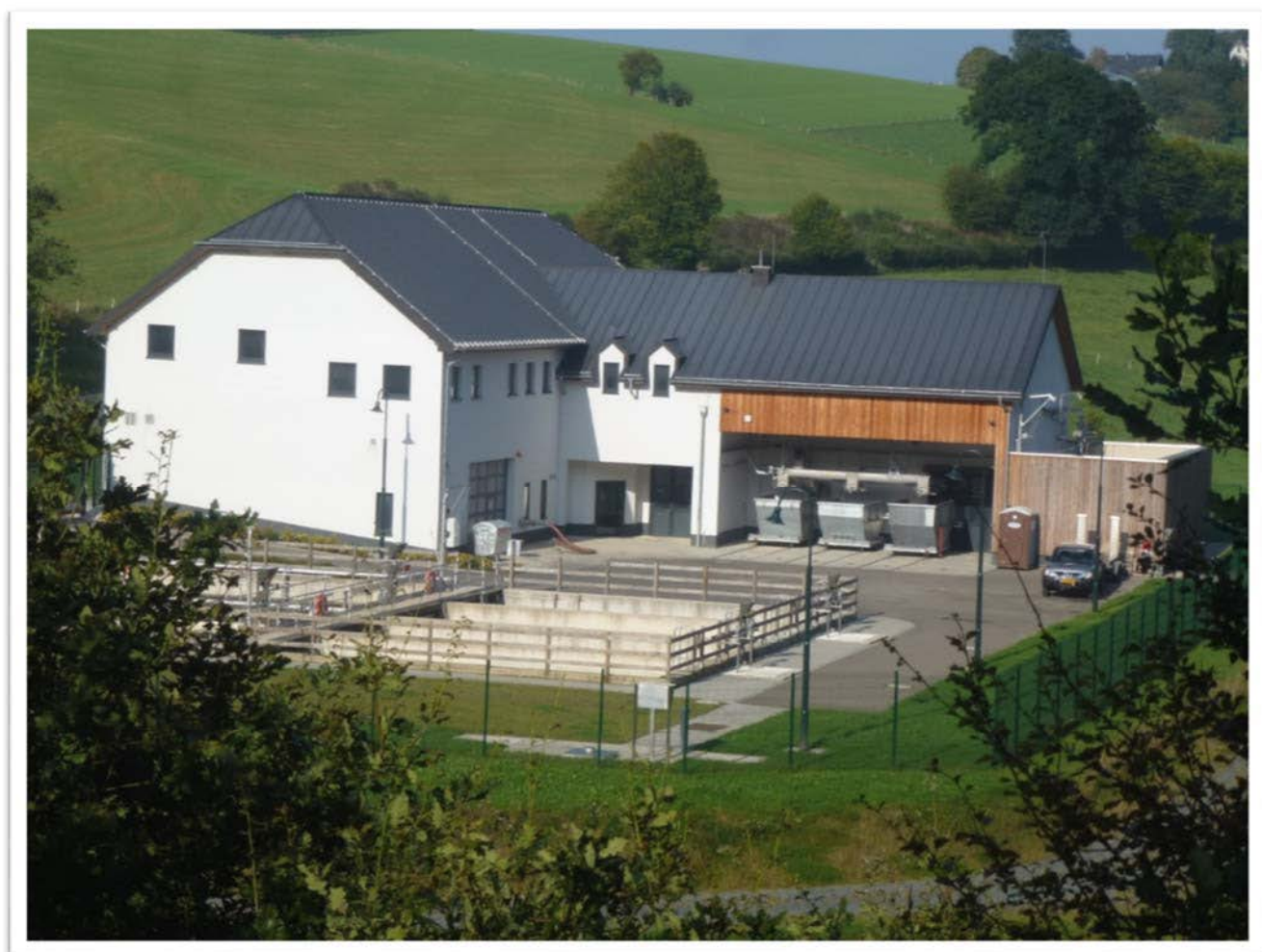
Vue sur la station d'épuration de Boevange / Wincrange
