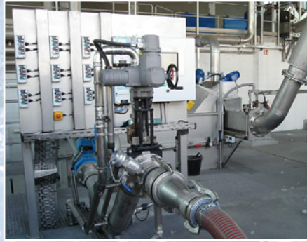
Station de réception pour vidangeuses Saugwagenannahmestation
