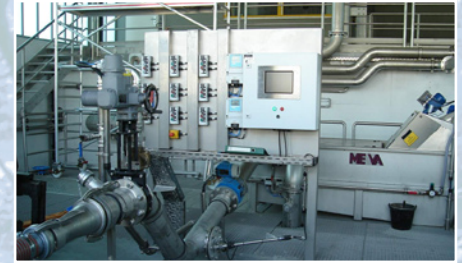
Station de réception pour vidangeuses Saugwagenannahmestation
