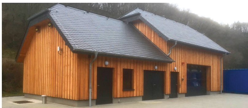
Betriebsgebäude Kläranlage Hoschied
