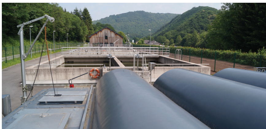
Vordergrund: abgedeckten Eindicker. Hintergrund: SU-Becken
