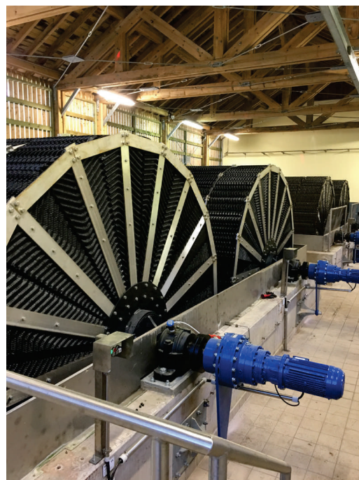
Vordergrund: Fertigstellung der 2. Stufe Hintergrund: 1. Stufe bereits in Betrieb
