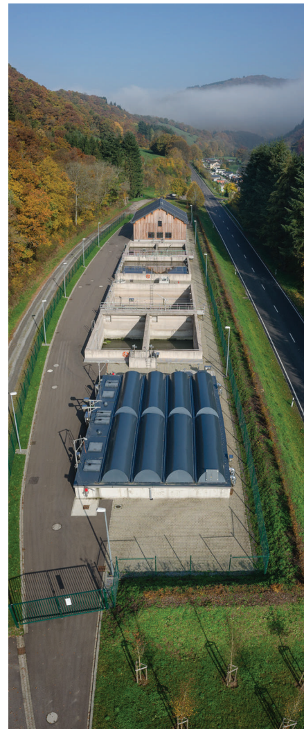
Gesamtansicht der Anlage
