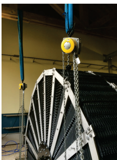
Montagearbeiten eines Scheibentauchkörpers
