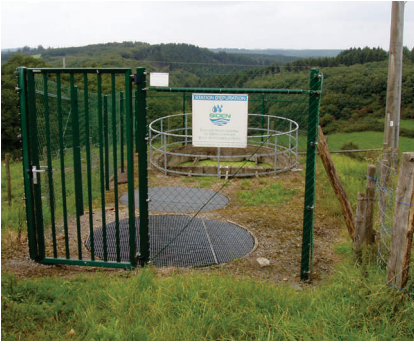
Aktuelle Kläranlage Bockholtz
