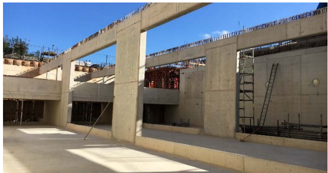
Photo: Bassin d'orage à Ettelbruck-Gare
