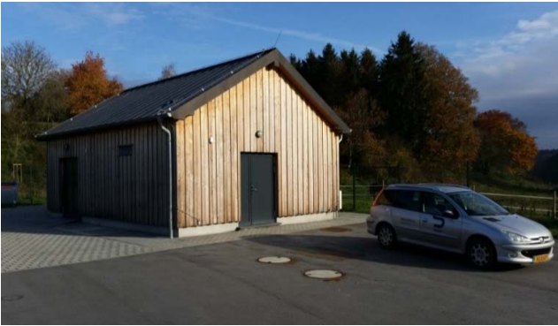
Photo: Bassin d'orage à Baschleiden
