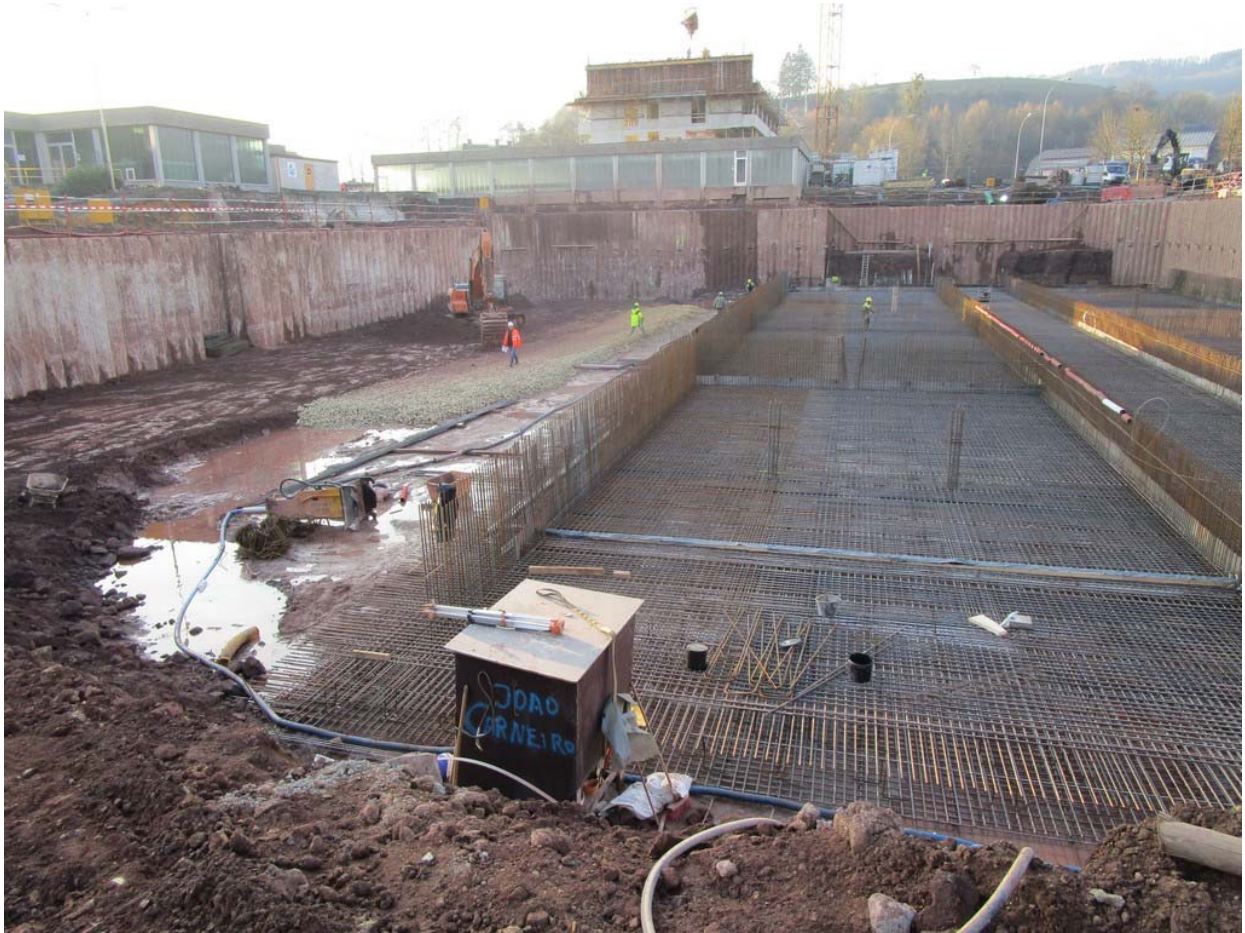
Photo: Chantier Blesbruck Phase II - Préparation bétonnage radier bassins biologiques
