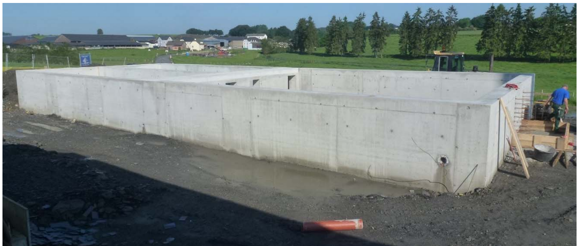
Photo: Bassin biologique de la future station d'épuration de Troine (1.400 EH)
