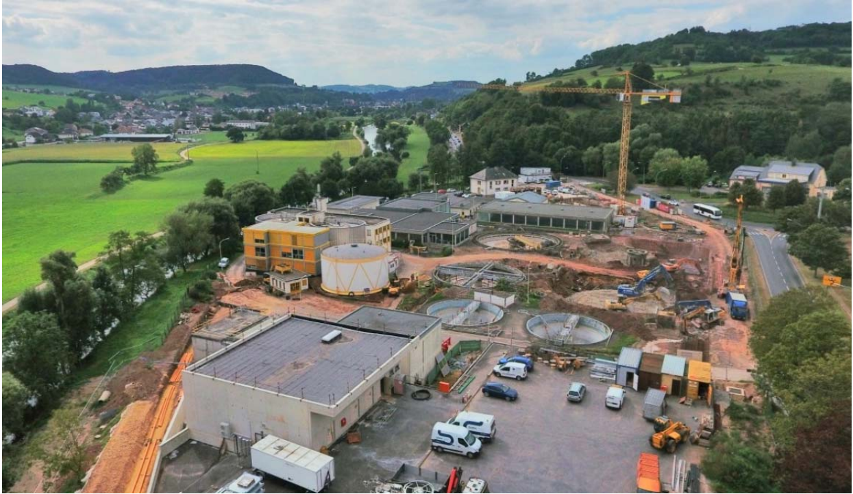
Photo: Démolition ancienne voie de traitement biologique à Blesbruck - Phase II
