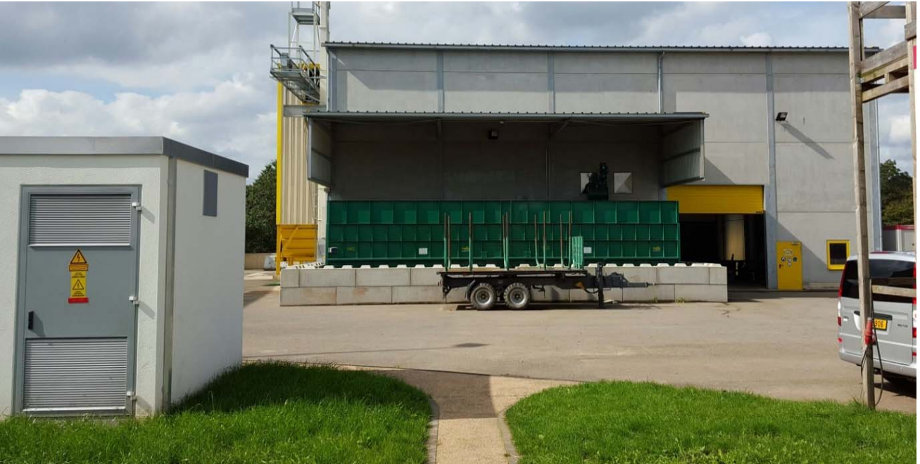
Fig 2: Hall des installations techniques d'ENERCOM et VALORTECH construit en 2012.
