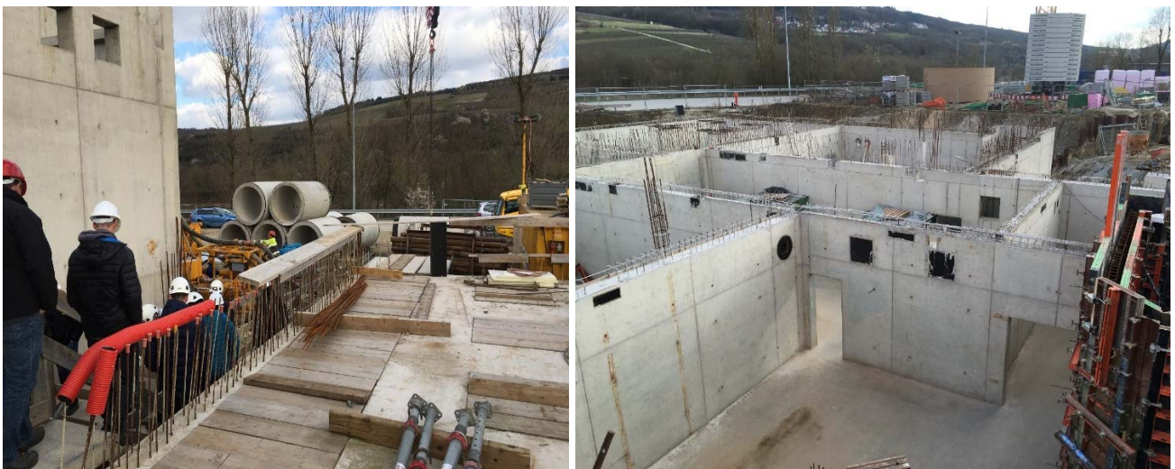
Visite du chantier de la station d'épuration de Grevenmacher (23.03.2016)
