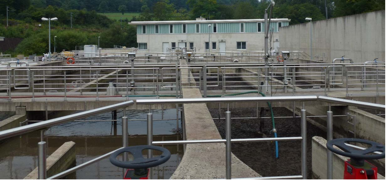
Photo: Station d'épuration à Wiltz - Nouvelle voie de traitement biologique et nouveau bâtiment technique
