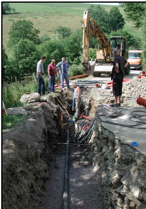
Siicht op de Chantgën vum Bau vun enger Oofwaasserleitung
