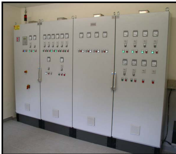
Schaltschîef vun der Kläranlag
