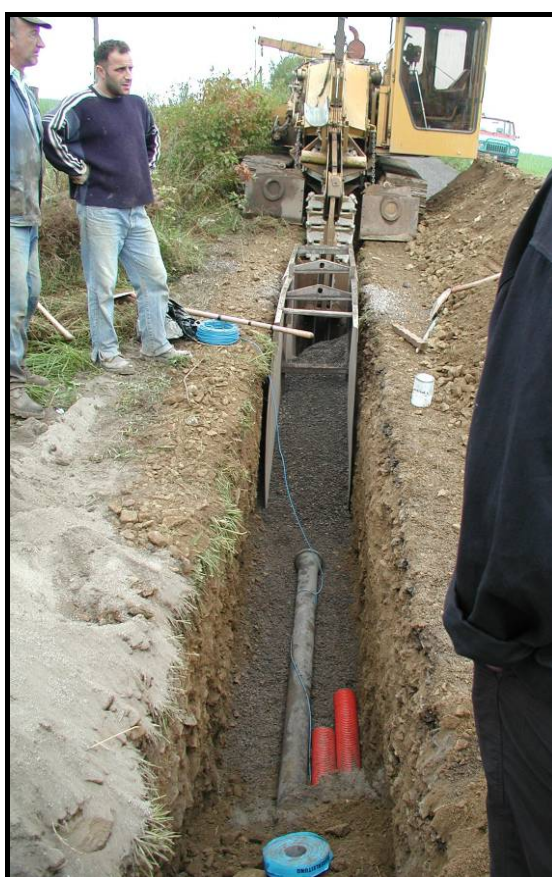
Siicht op d'Verléën vun der Drockoofwaasserleitung mat enger Buëdemfräs
