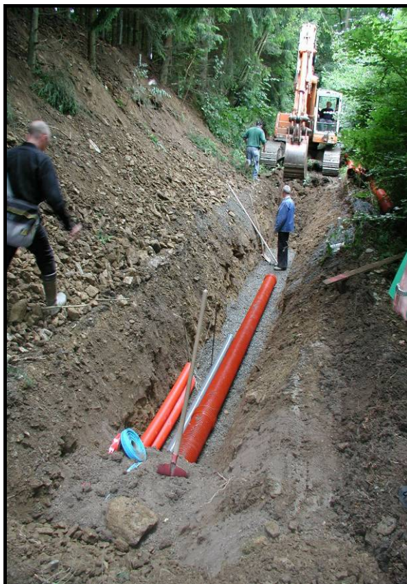
Siicht op de Chantgën vum Bau vun enger Oofwaasserleitung
