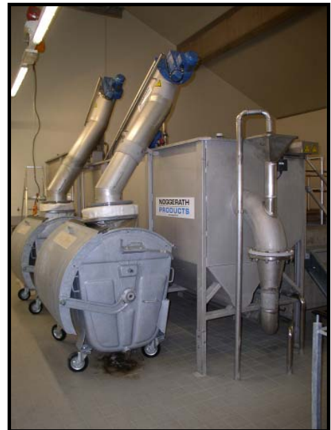
Schema a Siicht op d'Kombianlag Fäinreech, Sand- a Fettfang
