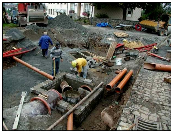
Kanalisationssarbichten am Zentrum vun Huesen
