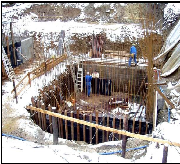
Siicht op d'Fondatiounsarbechten vun den Oofsaazbecken vun der Kläranlag
