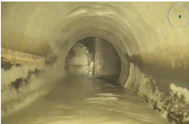
Kanal nach Sanierung
