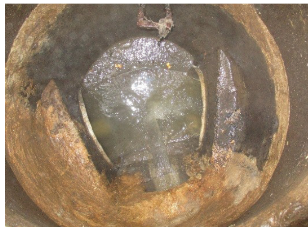
Schacht vor Sanierung
