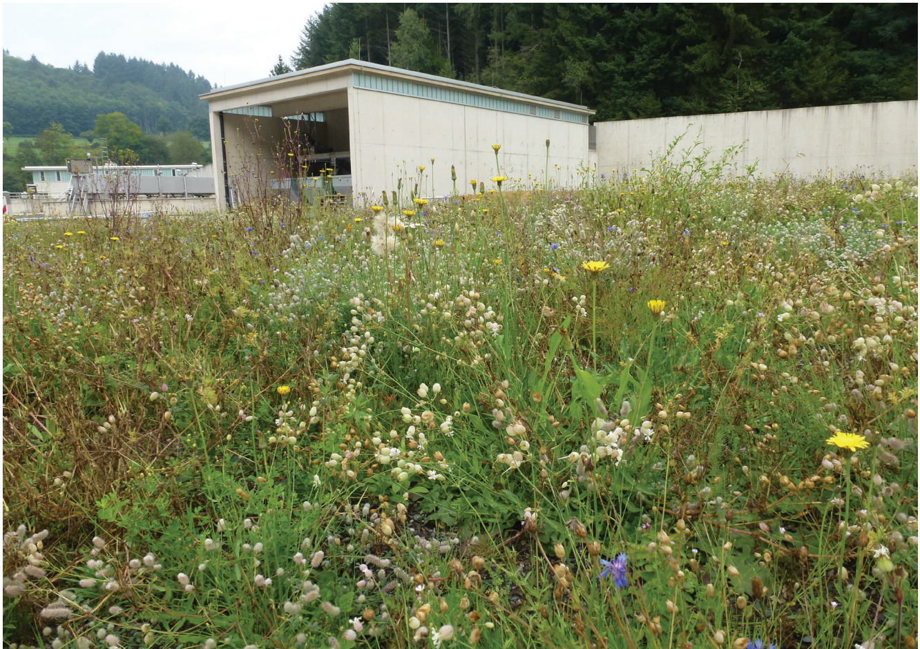
Blumenwiese; Schlammbehandlungsgebäude und Betriebsgebäude im Hintergrund
