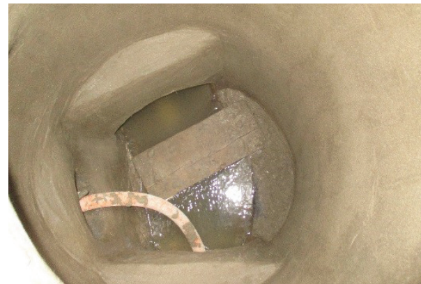
Schacht nach Sanierung
