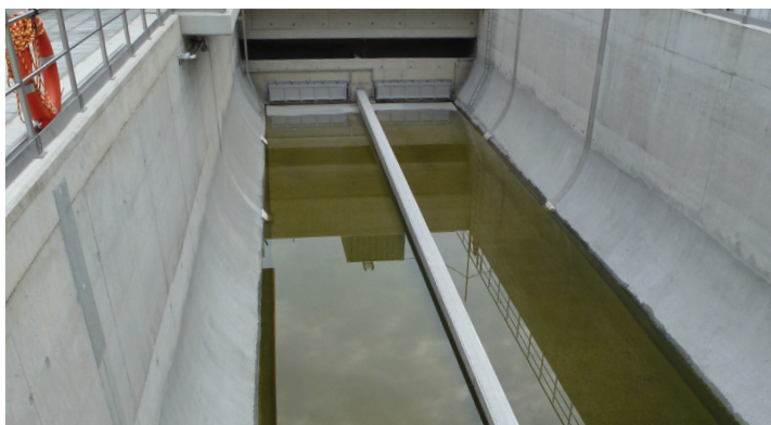
RÜB Kläranlage Wiltz
