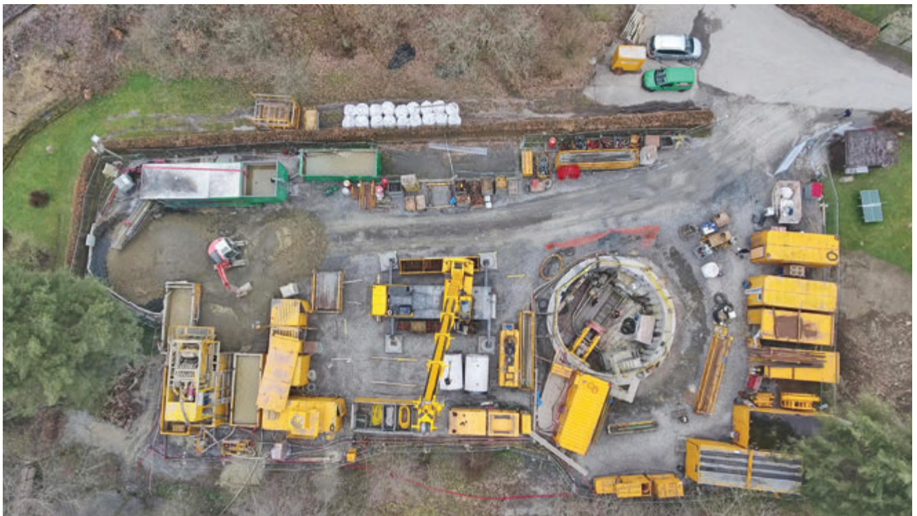
Luftbild einer Pressgrube
