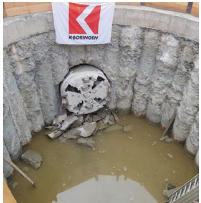
Der Bohrkopf erreicht die Zielgrube
