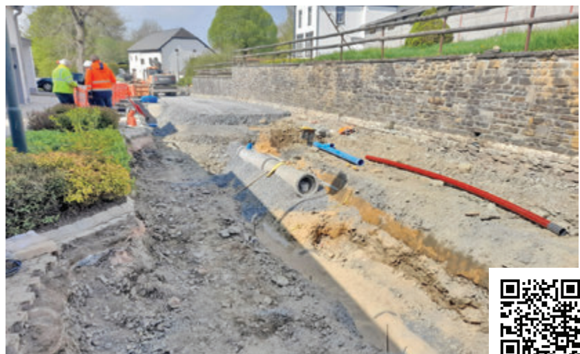
PW Niederbesslingen (Bau)
