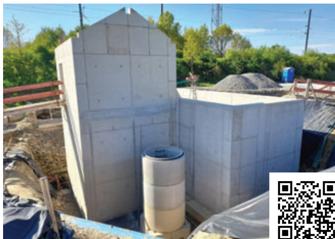
Baufortschritt Rüb Oberbesslingen
