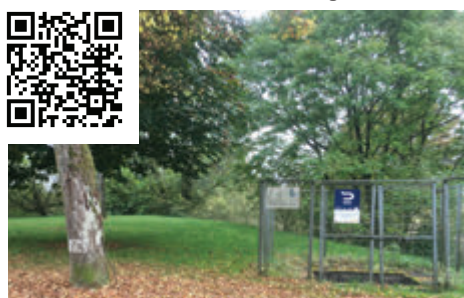
Bestehende mechanische Kläranlage Niederbesslingen
