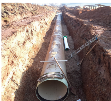
Travaux de pose du collecteur
