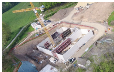
Vue aérienne du chantier
