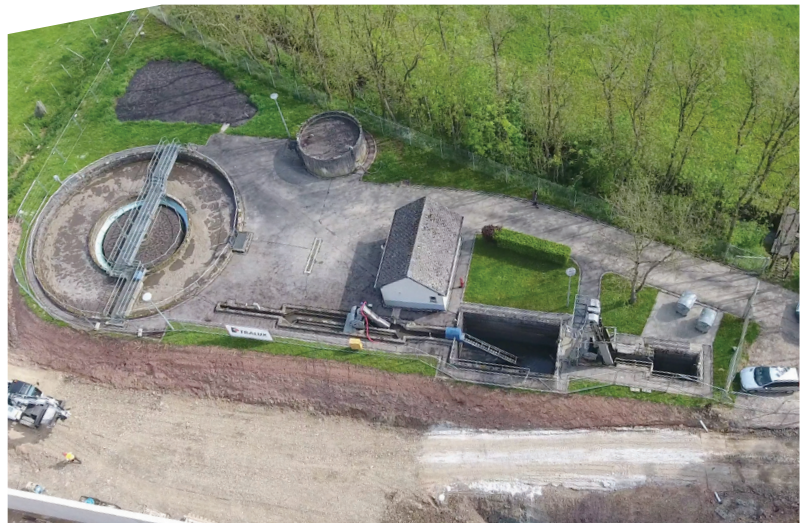
Station d'épuration existante qui sera démolie
