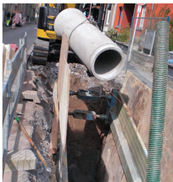
Travaux de canalisation dans la rue du Canal / Kanalarbeiten in der rue du Canal
