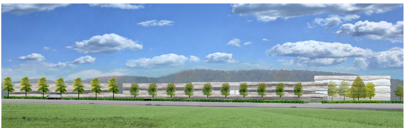
Vue direction Vianden / Ansicht der Anlage aus Vianden kommend
