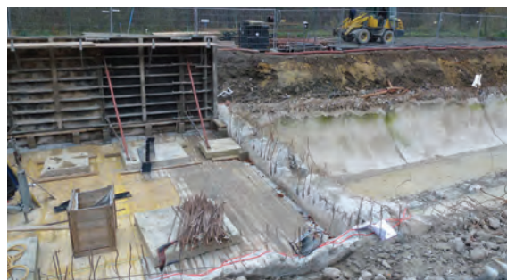
Préparation silo à boues et bassin d'orage / Vorbereitungsarbeiten Schlamm-silo RÜB
