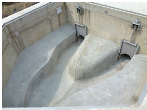
Ouvrage de sortie / Auslaufbauwerk
