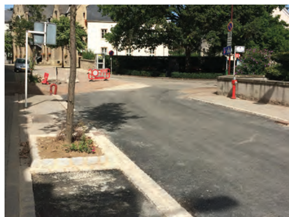
Réaménagement de la rue du Canal / Instandsetzung der rue du Canal
