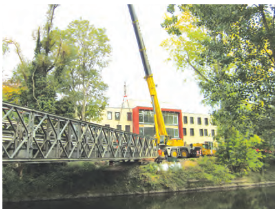
Démontage du pont provisoire sur l'Alzette / Abbau der provisorischen Brücke über der Alzette
