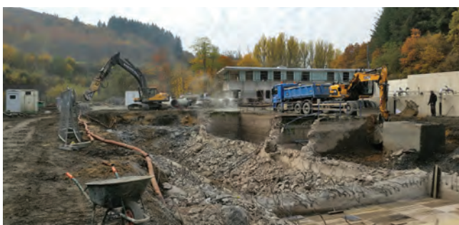
Travaux de démolition de l'ancien bassin de biologie / Abrissarbeiten der ehemaligen Biologie
