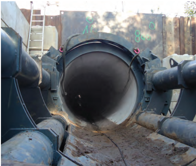
Fonçage Ø1600 sous les voies ferrées CFL / Durchpressung unter den CFL Bahngleisen
