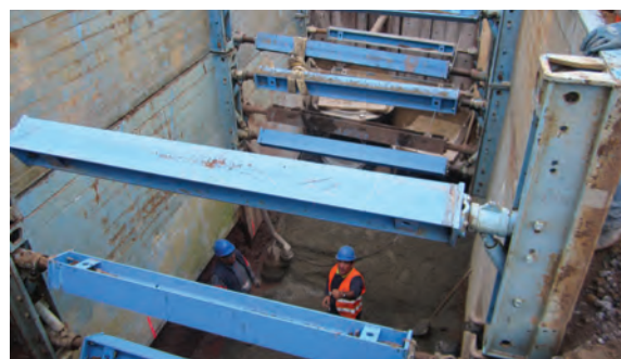
Blindage lourd pour travaux de canalisation / Grabenabsicherung für die Kanalverlegung
