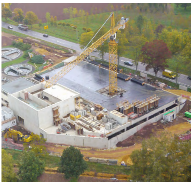
Vue aérienne de la phase 1 / Luftbild der Arbeiten der Phase 1
