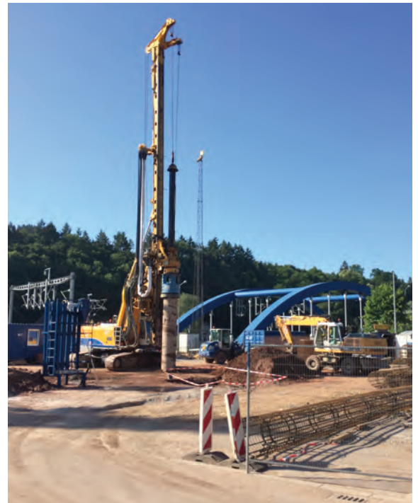
Forage de pieux pour le bassin d'orage / Bohrpfähle für das Regenüberlaufbecken
