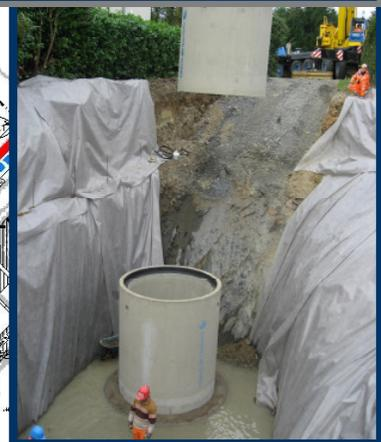
Pose des éléments préfabriqués de la station de pompage
