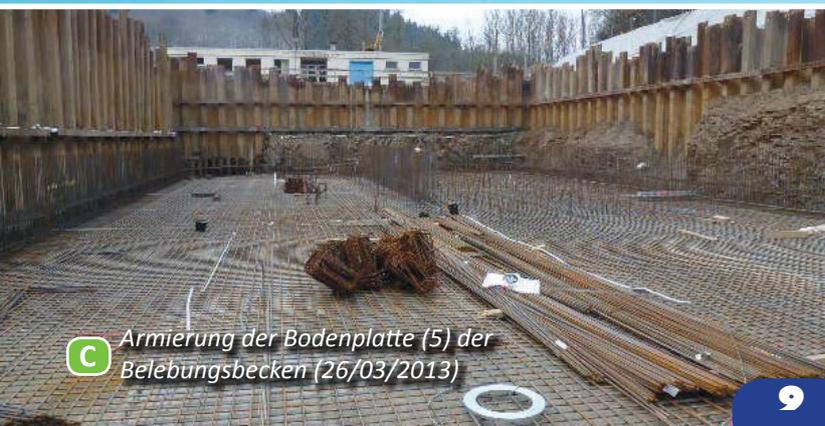
**C** Armierung der Bodenplatte (5) der Belebungsbecken (26/03/2013)
