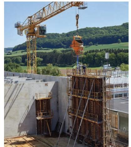
Betoniervorgang einer Stahlbeton-Wand der neuen Werkstatt
