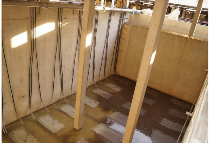
Test der Belüfterplatten mit Klarwasser
