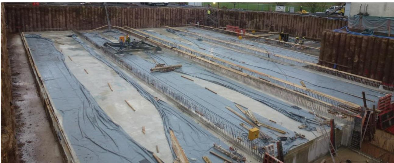
Phase 1: Betonieren der Bodenplatte der Nachklärung
