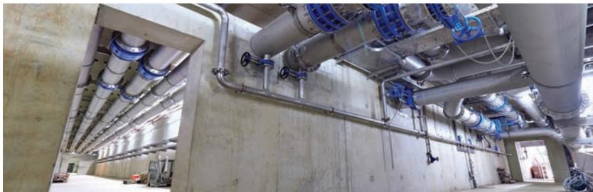
Zulaufleitungen zu den drei parallel geschalteten Belebungsbecken sowie Bypassleitungen im Kellergeschoss.
