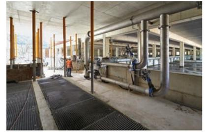
Auslauf Belebungsstufe und Verteilerschacht zur Nachklärung
