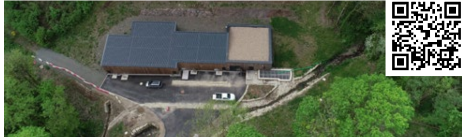
Vue extérieure / Externe Ansicht
