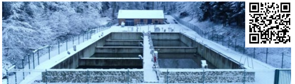
Vue extérieure / Externe Ansicht
