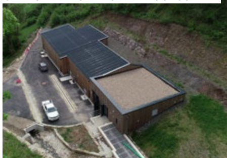
STATION D'ÉPURATION DE BOURSCHEID
