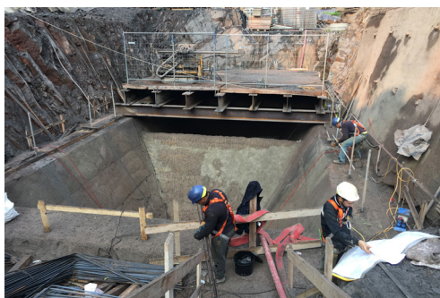
Fosse Emscher en phase chantier
