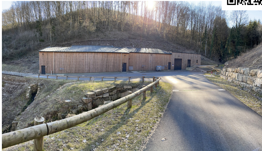
Vue générale sur la station d'épuration de Bourscheid
