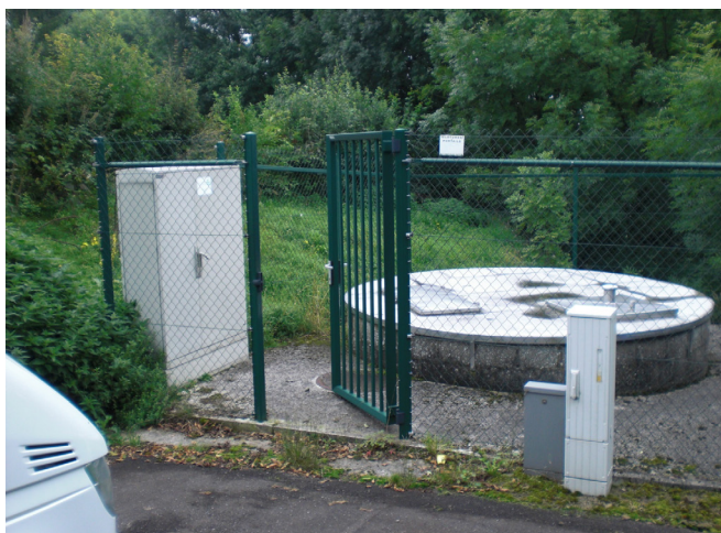
Ancienne station de pompage de Kehmen
