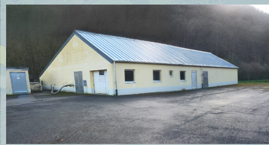
Station d'épuration Michelau 2250 EH
