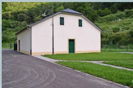
Station d'épuration Welscheid 350 EH
