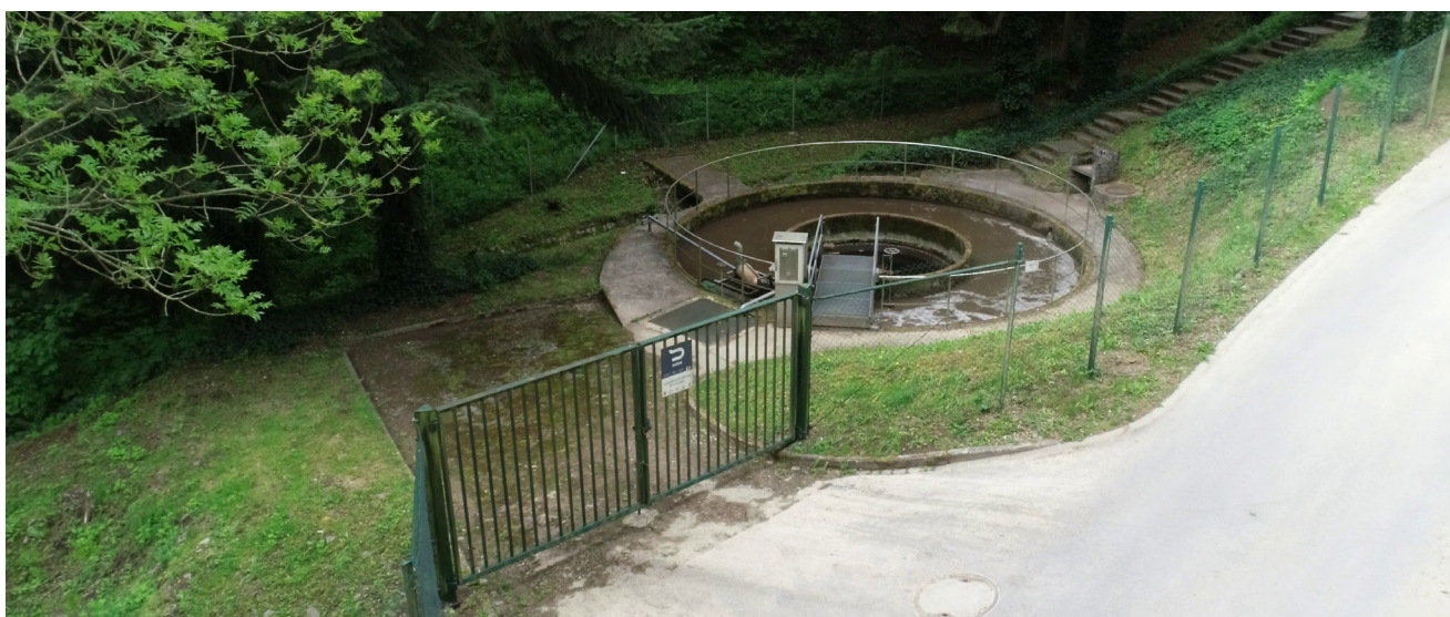
Ancienne station d'épuration de Bourscheid démolie en 2020
