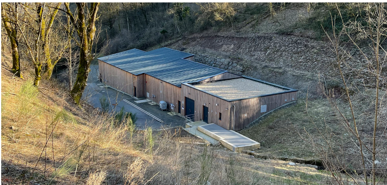
Vue sur la station d'épuration
