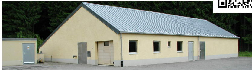
Station d'épuration de Michelau
