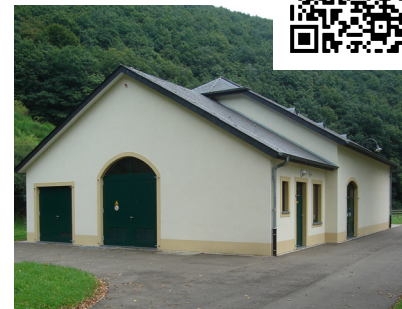
Station d'épuration de Welscheid
