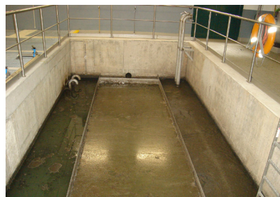
Vue du bassin de type Emscher
