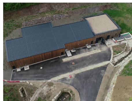
Vue aérienne de la station d'épuration en phase chantier
