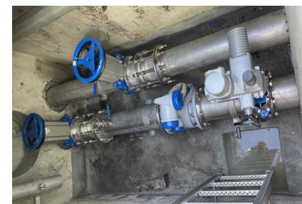
Mise en place d'un débitmètre électro-magnétique
