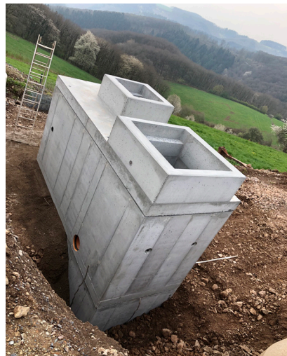
Station de pompage de Scheidel en phase chantier
