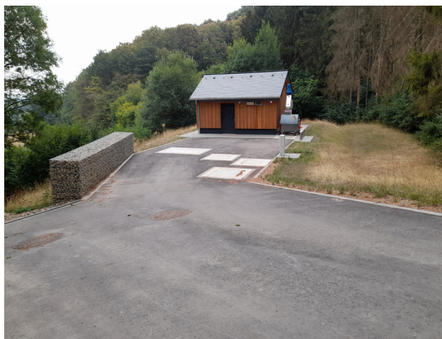
Nouveau bassin d'orage avec station de pompage de Kehmen
